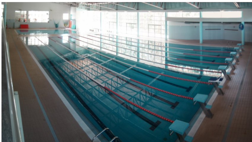
Figura 16 – Imagem da nave da piscina (comum para os dois tanques)
