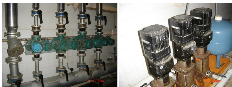
Figura 12 – Grupos de bombagem
