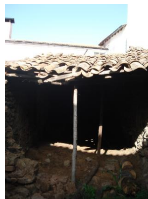
a) Construção vernacular com adobe, Bemposta, Portugal
