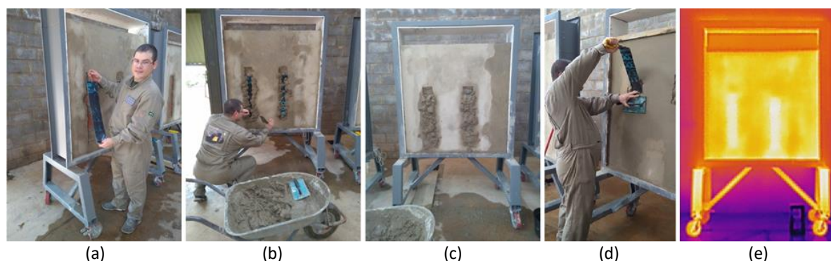
Figura 2 – Simulação de deslocamento de reboco externo às edificações. Fonte: o autor.
