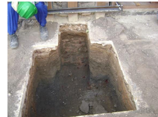
Figura 2: Investigação para verificar a existência do bloco de fundação, (Fonte: Arquivos IPHAN).
