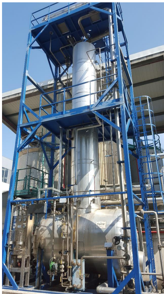
Figura 3. 2 - Fotografia da instalação da torre de retificação do metanol
