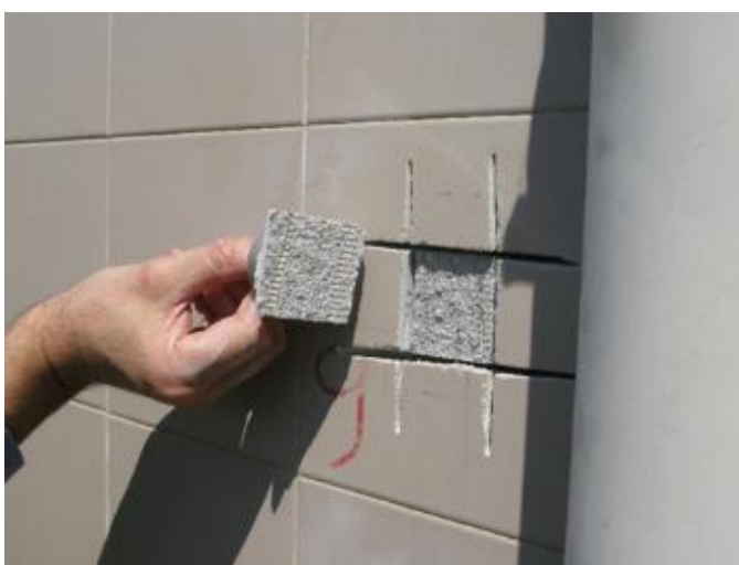
Figura 4.52 - Ensaio de arrancamento Ref.ª 9
