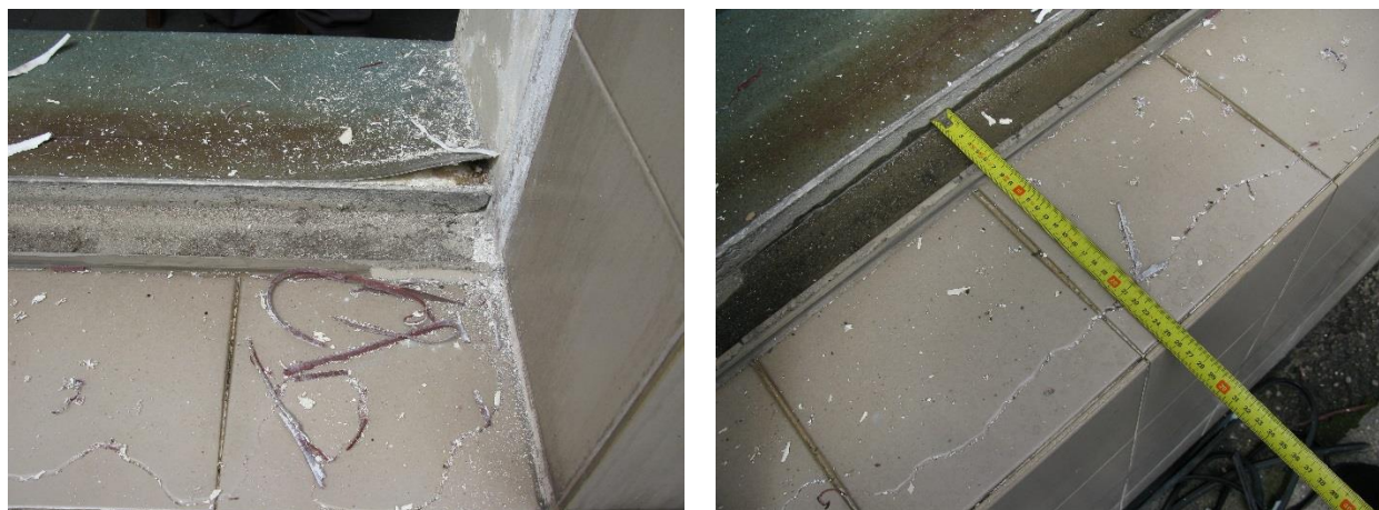
Figura 4.57 – Aspeto da ligação caixilharia/envolvente
