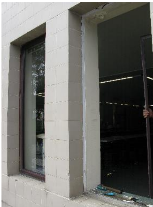
Figura 4.56 – Remoção do caixilho
