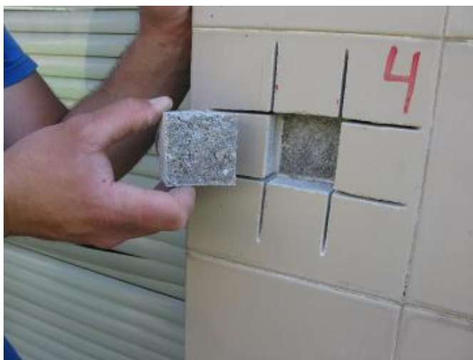
Figura 4.47 - Ensaio de arrancamento Ref.ª 4
