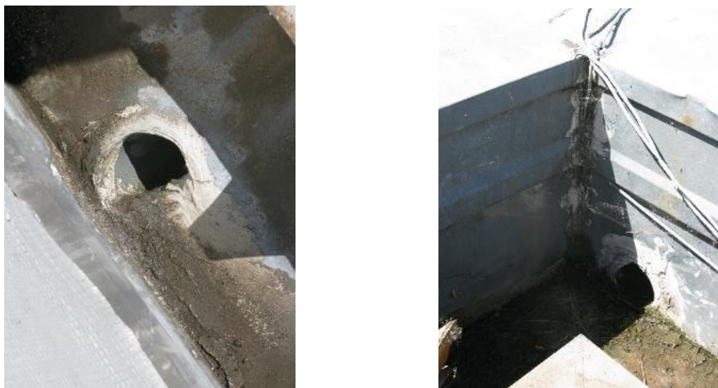
Figura 4.14 – Ligação existente entre o tubo de queda e a caleira, ligação entre rufos e ligação rufo tubo de queda
