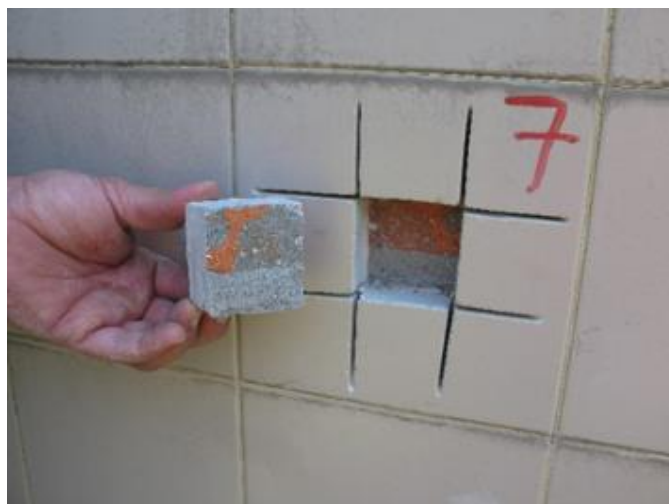
Figura 4.50 - Ensaio de arrancamento Ref.ª 7
