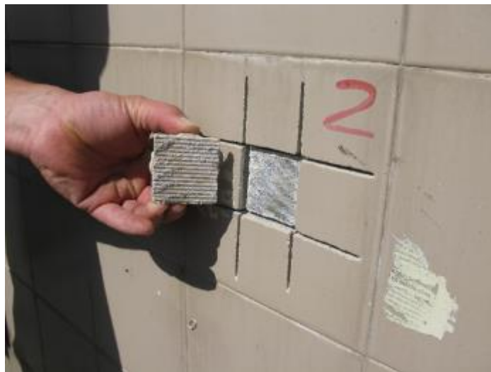
Figura 4.45 – Ensaio de arrancamento Ref.ª 2
