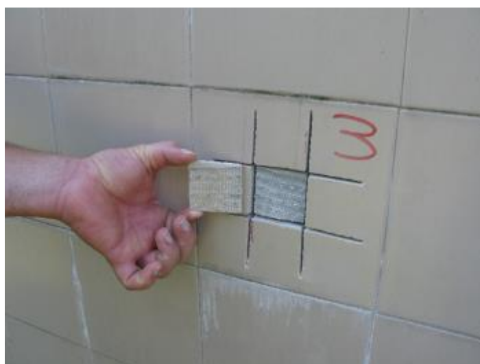
Figura 4.46 - Ensaio de arrancamento Ref.ª 3
