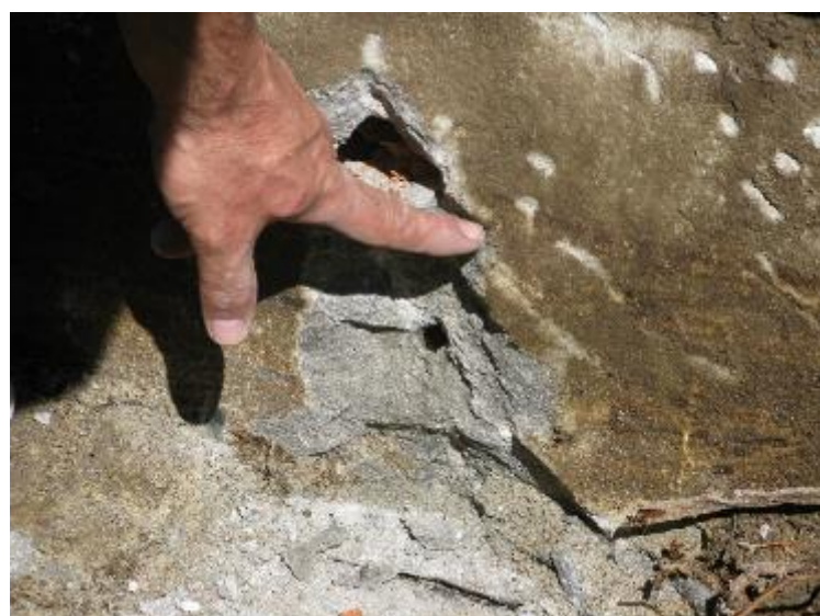
Figura 4.40 – Picagem a 25cm do fim do revestimento
