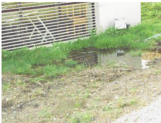
Figura 4.7 - Fachada voltada a norte do Corpo A.
