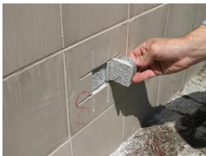
Figura 4.51 - Ensaio de arrancamento Ref.ª 8
