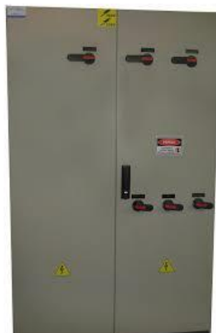
Figura 36 - Quadro Geral de Baixa Tensão (Fonte: ruthmann.com.br)
