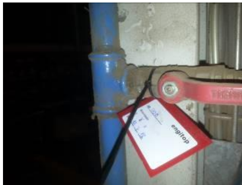
Figura 41 - Exemplo de uma fuga detetada
