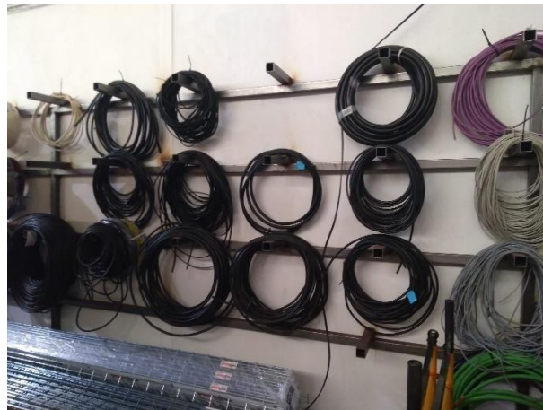
Figura 21 - Armazenagem da cablagem
