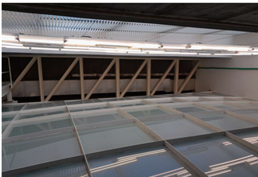
Figura 20 — Circuito de iluminação do Hall Central do Museu
