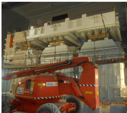
Figura 9: Transformador de potência 400kV em montagem
