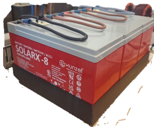
Figura 69 - Baterias instaladas em série
