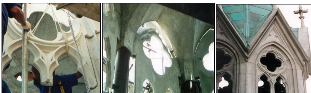
Figura 2.7 – Peças pré-fabricadas em GRC usadas na construção da Catedral da Sé (Construtora Concrejacto, 2002 apud FACCIO, 2004)
