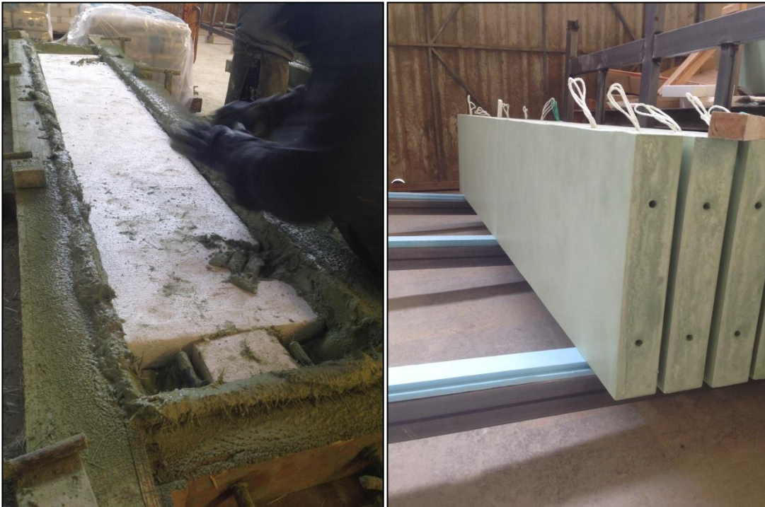
Figura 3.4 – Inclusão do isolante térmico no painel sanduíche (esquerda) e o painel pronto (direita) (Acervo próprio)
