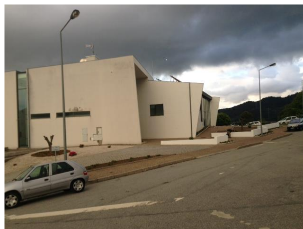
Figura 8: Vista Lateral das Piscinas Municipais de Armamar.
