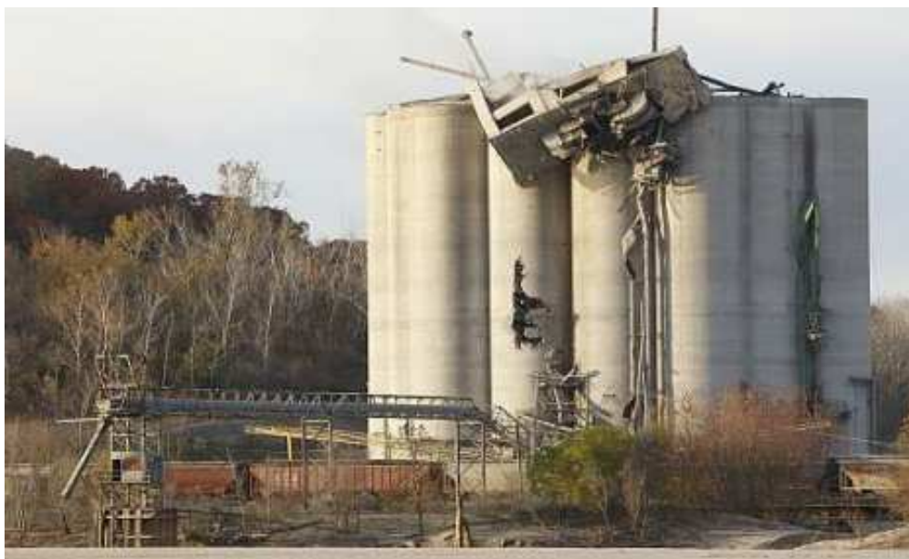
Figura 11 - Explosão num silo de armazenamento de cereais.
