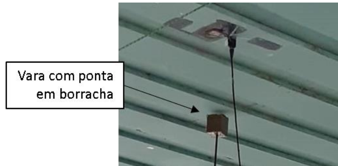
Figura 3.15 – Indução de pequenas vibrações na estrutura
