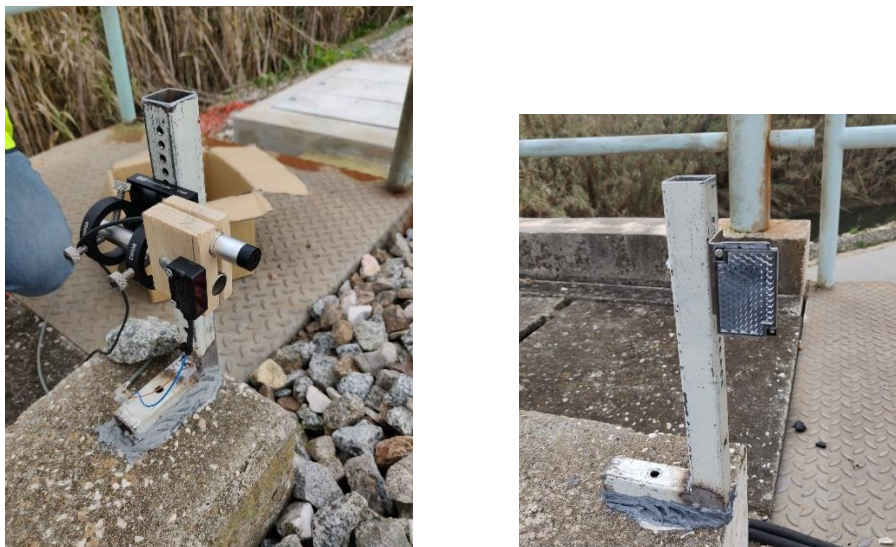
Figura 3.16 – Sistema de deteção da passagem de comboios
