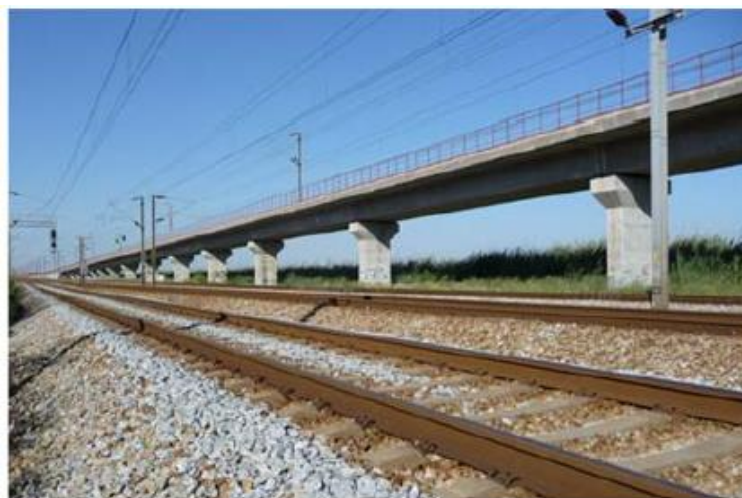
Figura 2.39 – Viaduto ferroviário Alverca (Malveiro et al. , 2013).
