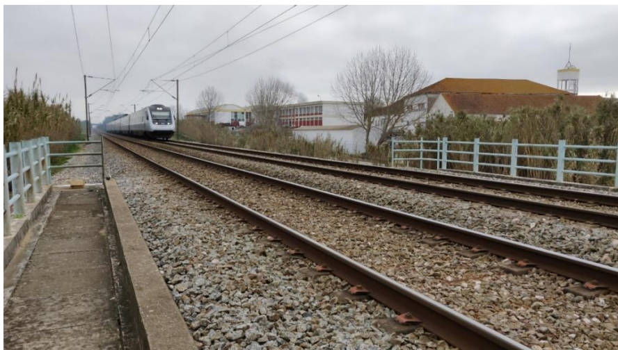
Figura 3.3 – Ponte da Cascalheira – via férrea
