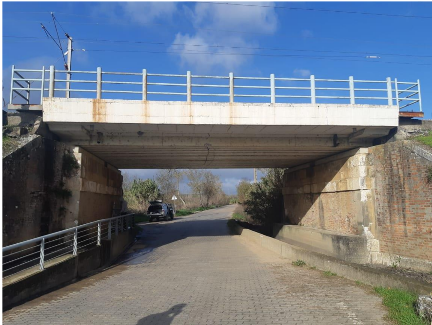
Figura 3.2 – Ponte da Cascalheira – vista longitudinal
