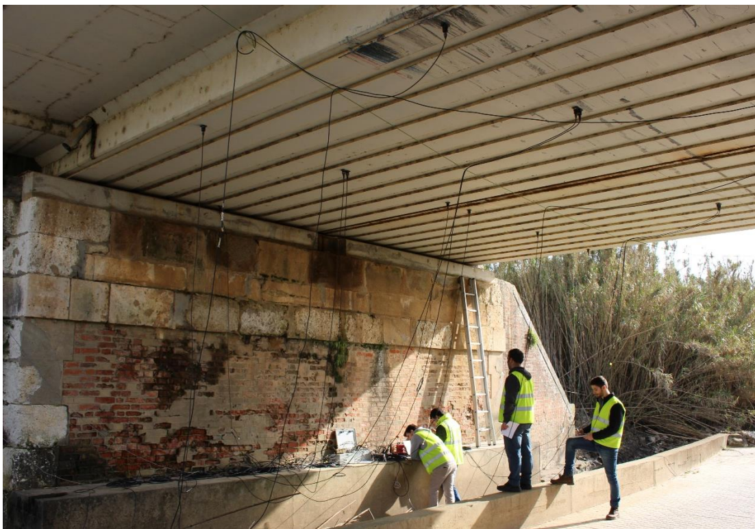
Figura 3.10 – Ensaio de vibração ambiental e de vibração forçada sob tráfego ferroviário.
