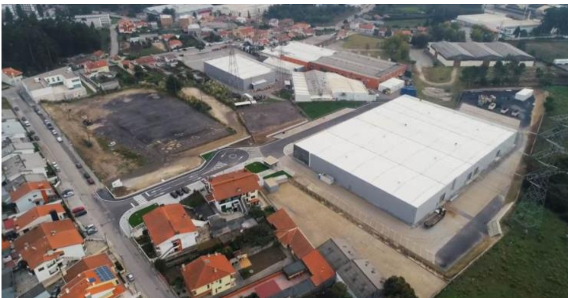
Figura 16 - Instalações da Fico Cables em Maia, Vermoim [96]
