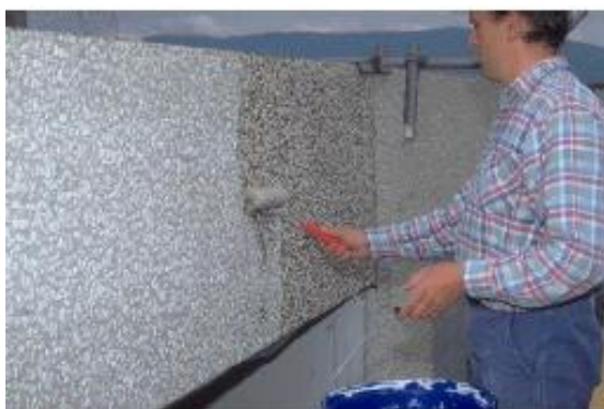
Fig. 5.18 – Aplicação de inibidores de corrosão.
