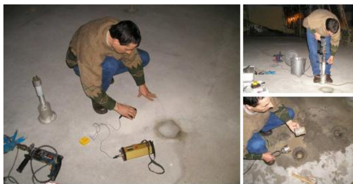
Fig. 3.12 – Localização de armaduras; realização do furo e extração da carote
