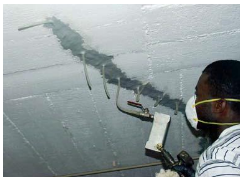
Fig. 5.23 – Injeção de resina de epóxido numa laje de betão armado
