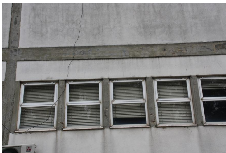
Fig. 6.11 – Mainéis em betão armado
