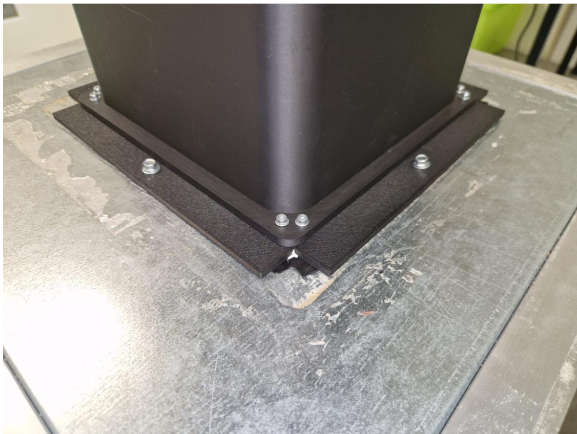
Figura 17 - Ligação do adaptador ao ventilador e secção reta
