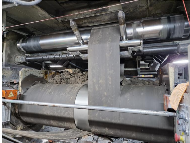
Figura 24 Gumix , com a banda a ser cortada pelas facas (zona inferior) e o stock blender (zona superior)
