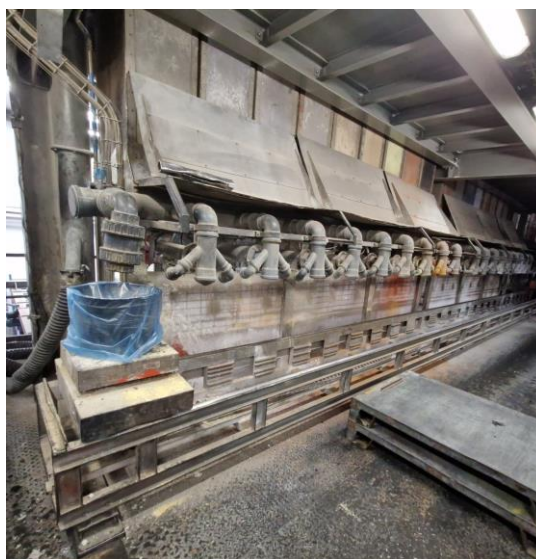
Figura 21 Cacifos de armazenamento de químicos e sistema de pesagem
