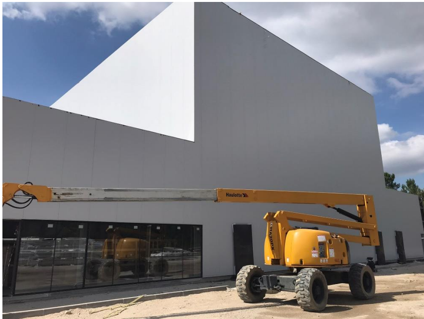
Figura 4.30 - Fachada lateral do edifício principal
