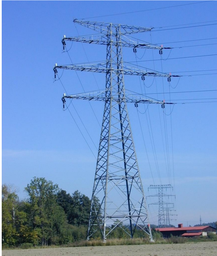
Figura 1.1 – Torre de ângulo
