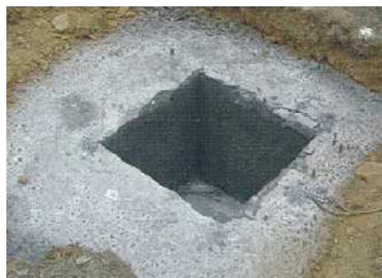
Figura 9 - Sapata betonada in situ (Lagartixo, 2011).
