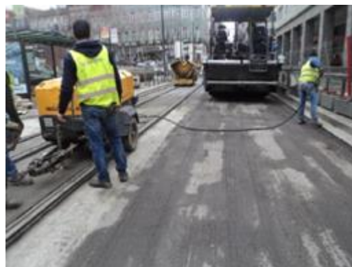
Figura 7.12 – Preparação para a pavimentação (2015)
