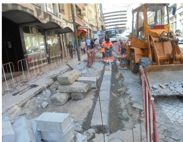
Figura 7.33 – Assentamento de lancis (2015)
