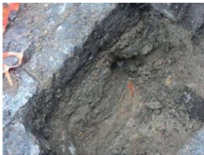
Figura 7.42 – Poço realizado na Rua de Santo Ildefonso (2015)
