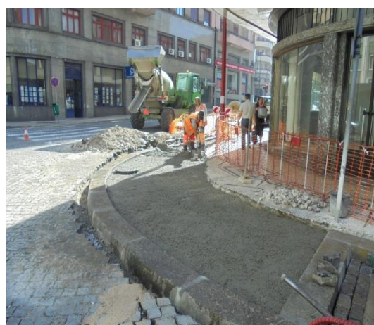
Figura 7.34 – Execução de pavimento em betão liso (2015)
