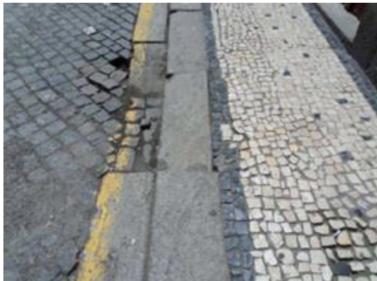
Figura 7.51 – Pavimento em microcubo de calcário na Rua da Alegria (2015)
