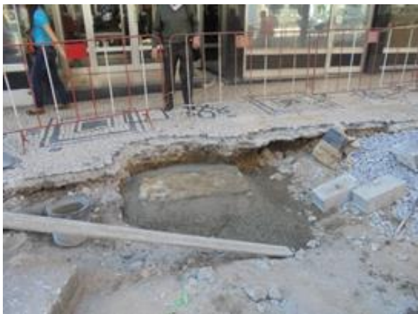
Figura 7.31 – Proteção de caixa com laje pré-fabricada (2015)
