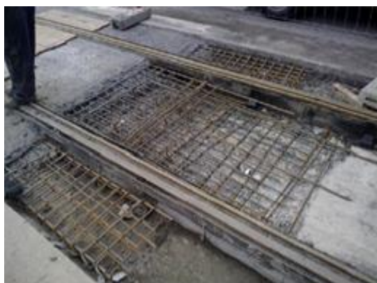
Figura 7.7 – Colocação de armaduras e betonagem (2015)
