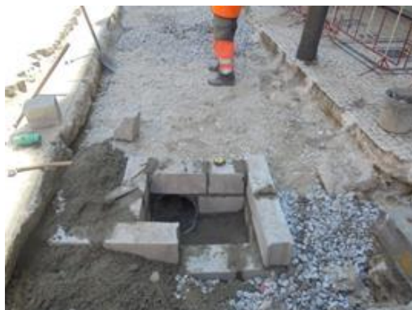
Figura 7.32 – Construção da nova caixa (2015)
