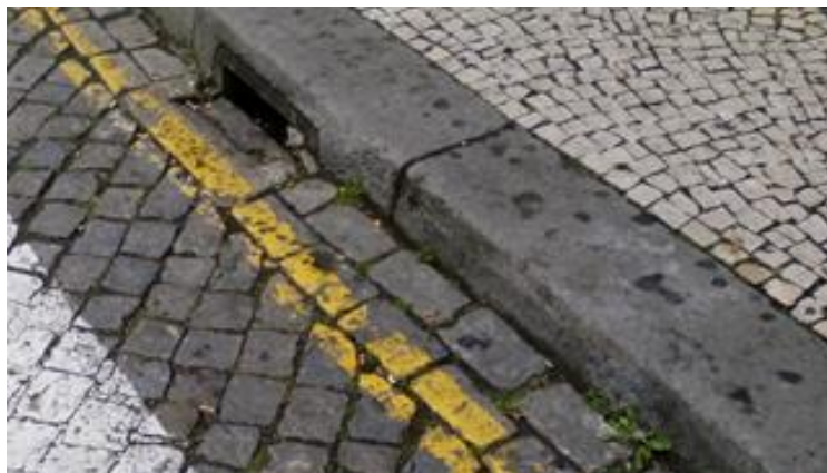
Figura 7.22 – Sarjeta boca de lobo (2015)
