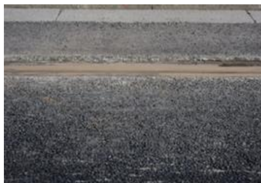
b) Nivelamento de pavimento junto ao carril
