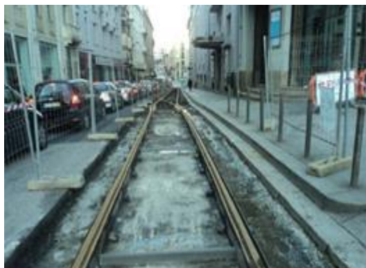
Figura 7.6 – Pavimento demolido da via da direita (2015)
