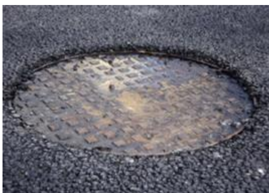
a) Nivelamento de Tampas
