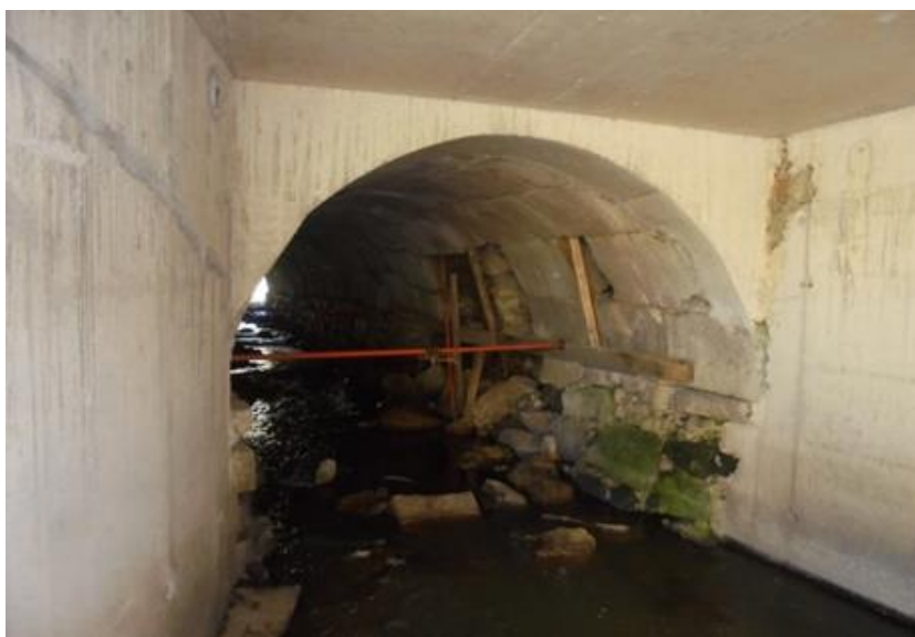
Figura 2.4 – Inspeção a Obra de Arte – Ribeira da Granja (2015)
