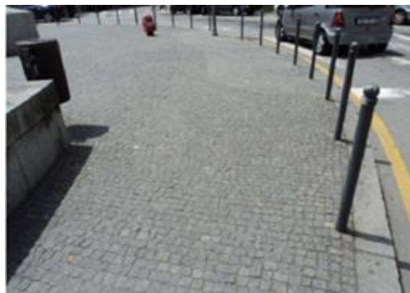
Figura 7.54 - Pavimento em microcubo de granito existente na Praça dos Poveiros (2015)
