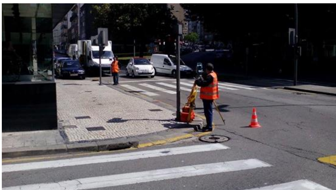
Figura 7.63 – Execução de levantamento topográfico (2015)
