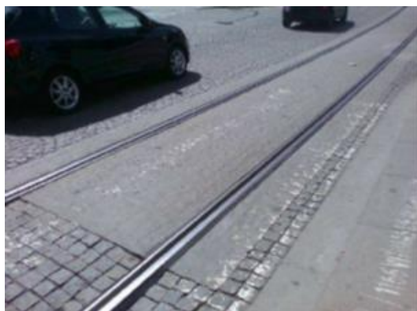
Figura 7.3 – Estado de conservação da laje pré-fabricada (Câmara Municipal do Porto, 2014)
