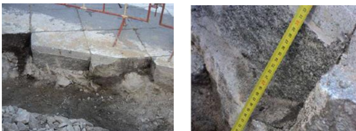
a) Poço Lajeado
