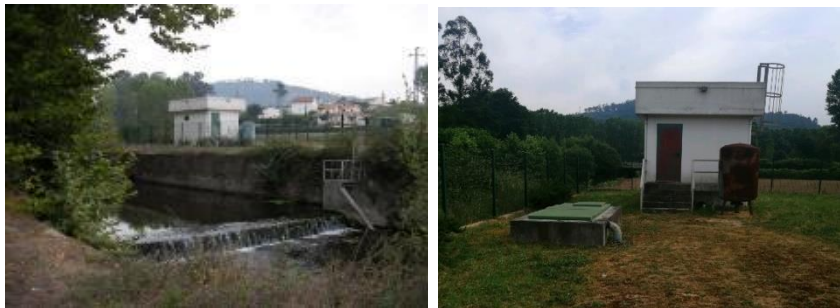
Figura A.I.10- Captação do Ferro (Fonte: AdDP)
