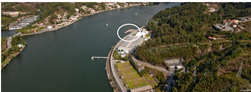
Figura 5-1- Localização no Complexo de Lever da Captação Superficial da ETA de Lever (Fonte: AdDP)
