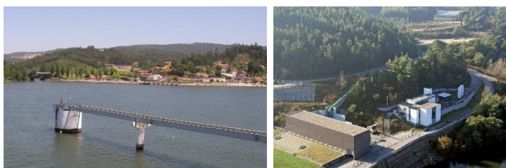
Figura A.I.1- Captação de Lever Jusante (Fonte: AdDP)
