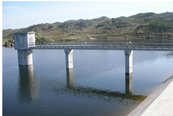
Figura 3-9-Torre de tomada de água: Barragem do Pinhão - Vila Real
