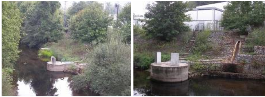
Figura A.I.9- Captação do Vizela (Fonte: AdDP)
