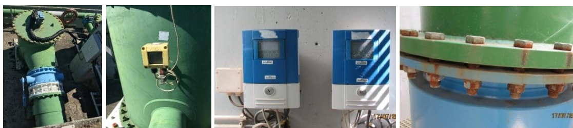
Figura 5-8- Fotografias recolhidas durante a inspeção (Fonte: Autora)
