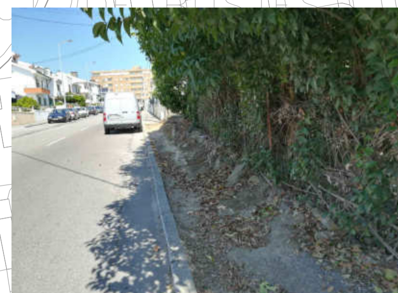
LANCIL DE BETÃO E CALÇADA DE PEDRA DO CHÃO
