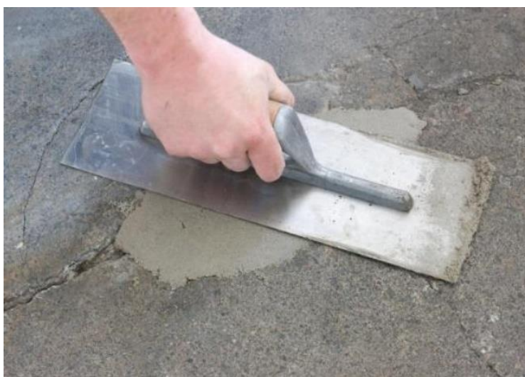
Figura 4.23 - Tratamento de fissuras superficiais
