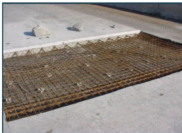
Figura 4.22 - Colocação de Armaduras
