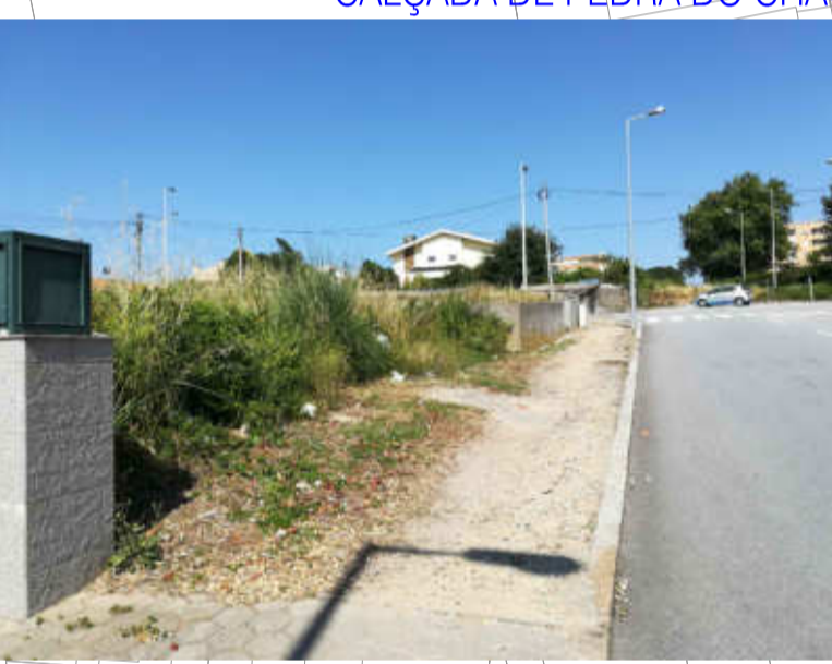
LANCIL DE BETÃO E CALÇADA DE PEDRA DO CHÃO
