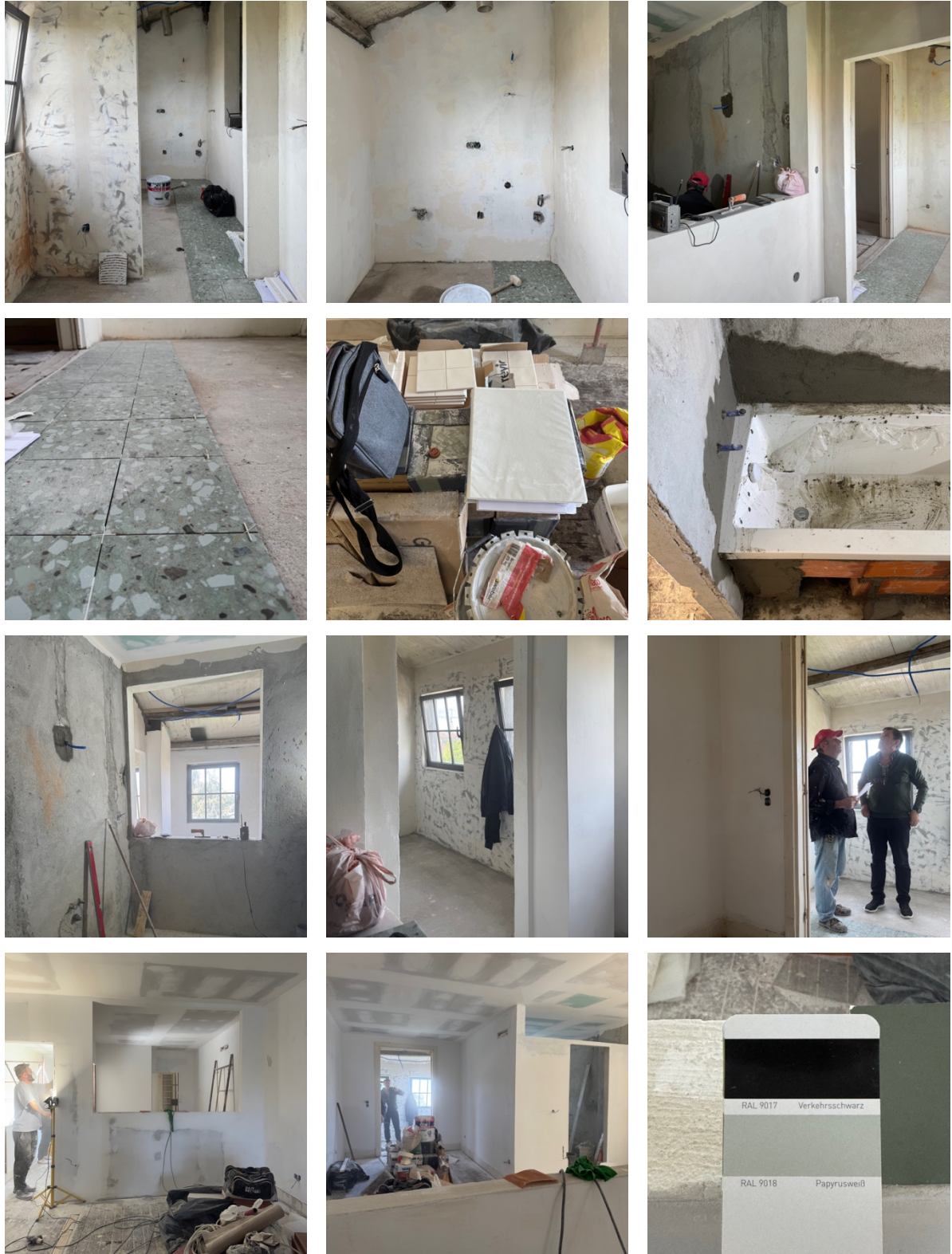
Anexo B – Projeto Cedofeita – Visita à Obra
