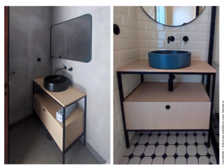
Lavatório | Estrutura metálica com tampo de madeira e tampo de vidro.
