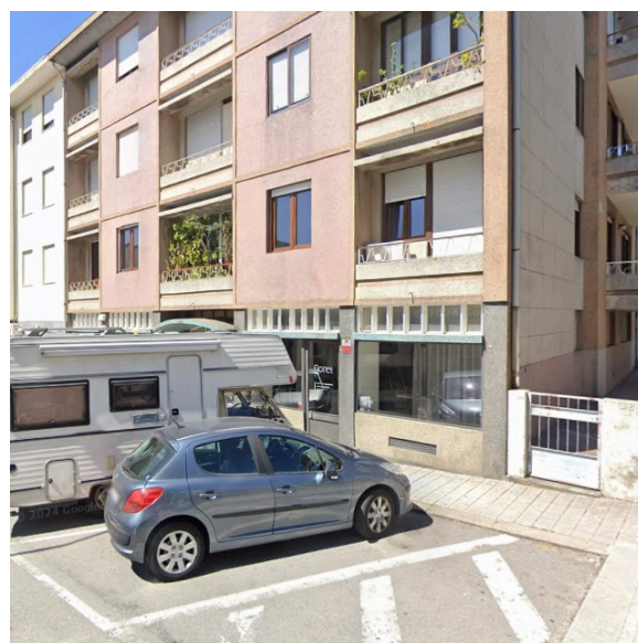
Figura 21 – Vista exterior do espaço do atelier Floret Arquitetura.
