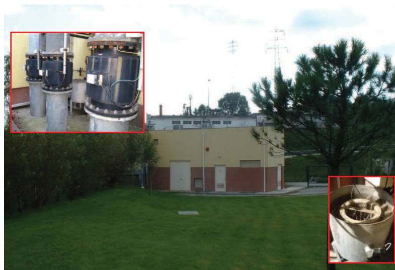
FIGURA 10: Câmara de chegada
