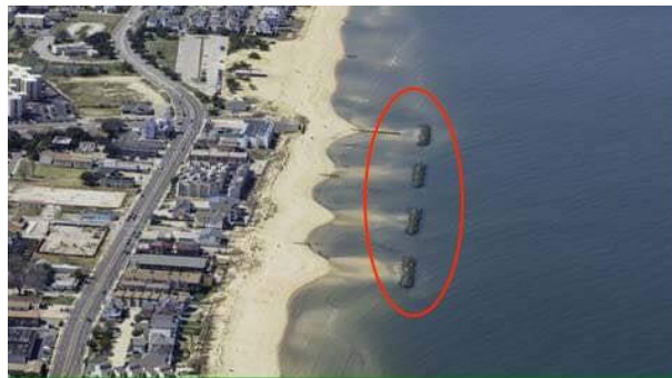
Figura 3 - Exemplificação de quebra-mares destacados.
