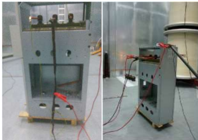
Figura 49 Montagem do ensaio numa cela de distribuição secundária.
