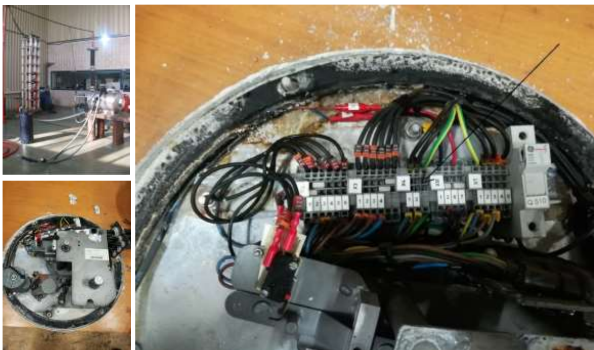
Figura 61 Vista frontal do IAT após ensaio do arco interno.
