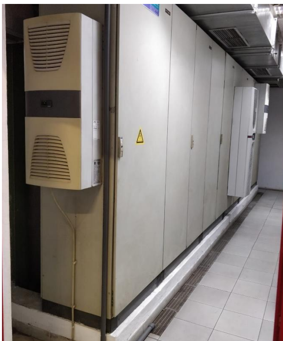
Figura 22 - Parte do quadro da máquina de impregnar Zell
