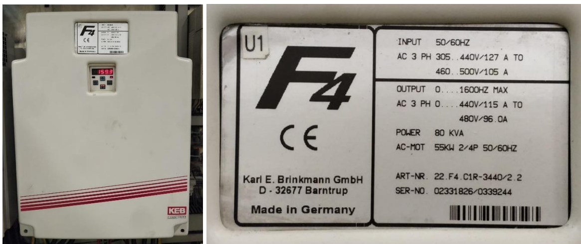
Figura 34 – a) Variador de velocidade KAB, b) Chapa de características do variador de velocidade KAB
