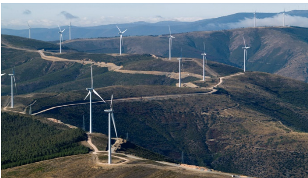
Figura 4 - Parque Eólico da Serra dos Candeeiros
