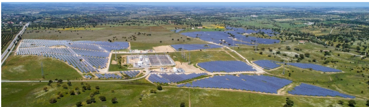
Figura 5 - Central fotovoltaica de Ourika 2
