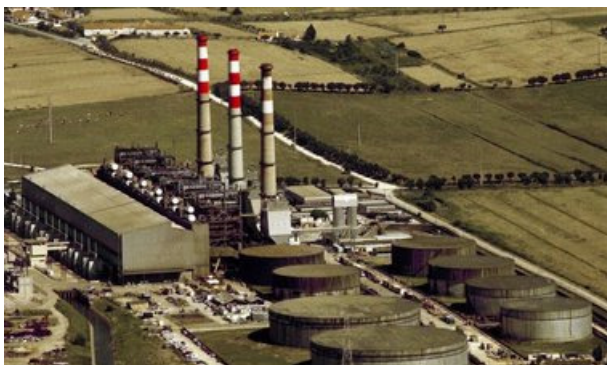
Figura 2 - Central Termoelétrica do Carregado
