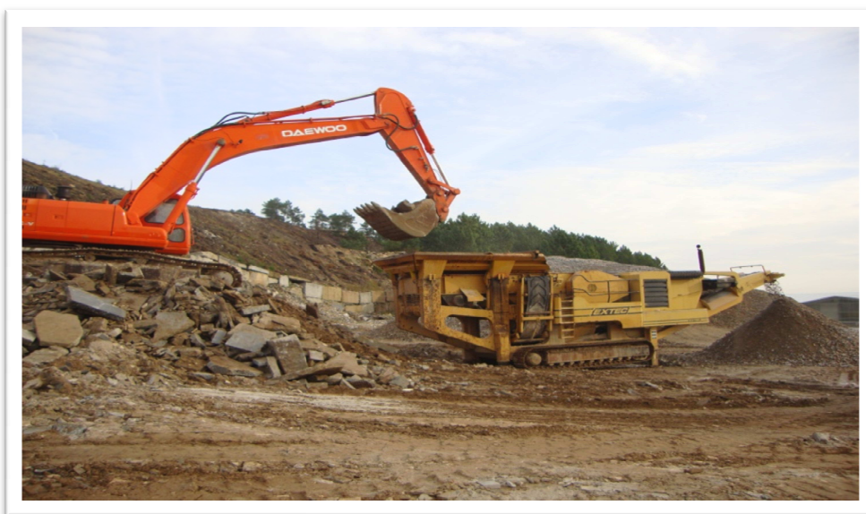
Figura 16 Equipamento móvel de britagem
