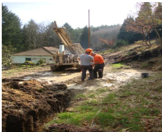
Figura 5.70 - Colocação do eléctrodo de cobre no primeiro furo artesiano
