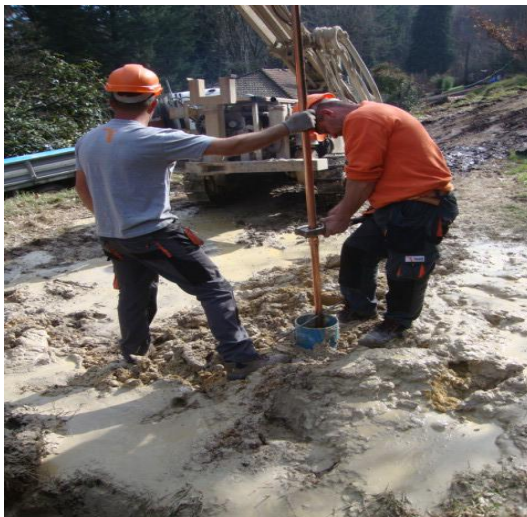
Figura 5.73 - Colocação do eléctrodo de cobre no segundo furo artesiano
