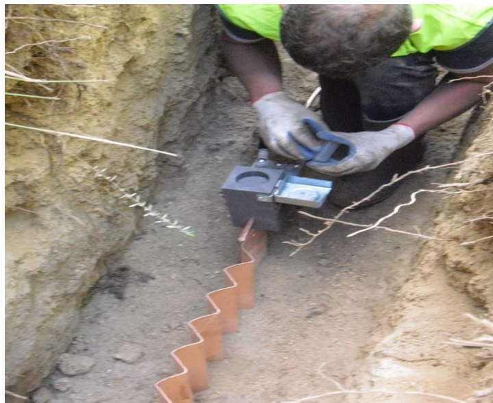
Figura 3.1 – União da chapa de cobre ao eléctrodo horizontal através do processo de soldadura com pólvora
