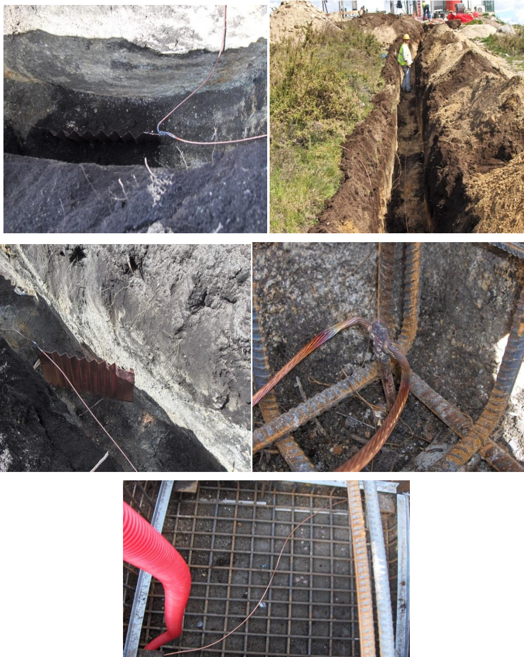
Figuras 5.34, 5.35, 5.36, 5.37 e 5.38 – Realização da rede terras standard
