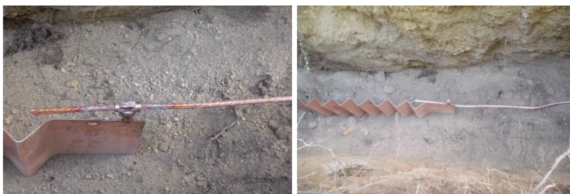
Figuras 5.22 e 5.23 – Colocação das chapas de cobre em vala
