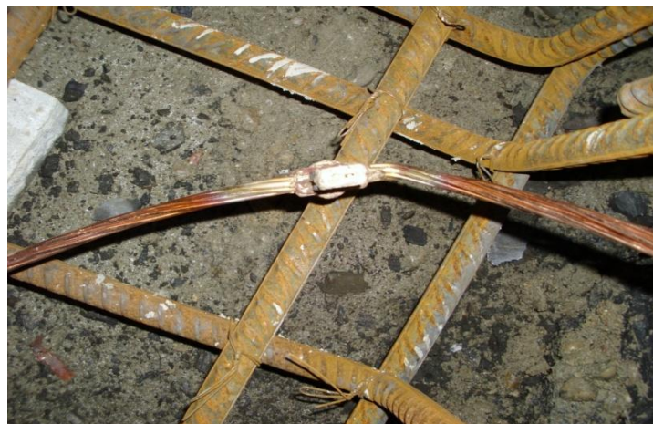
Figura 2.5 – Soldadura de interligação da armação ao circuito de terras
