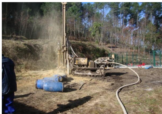
Figura 5.69 – Realização do primeiro furo artesiano
