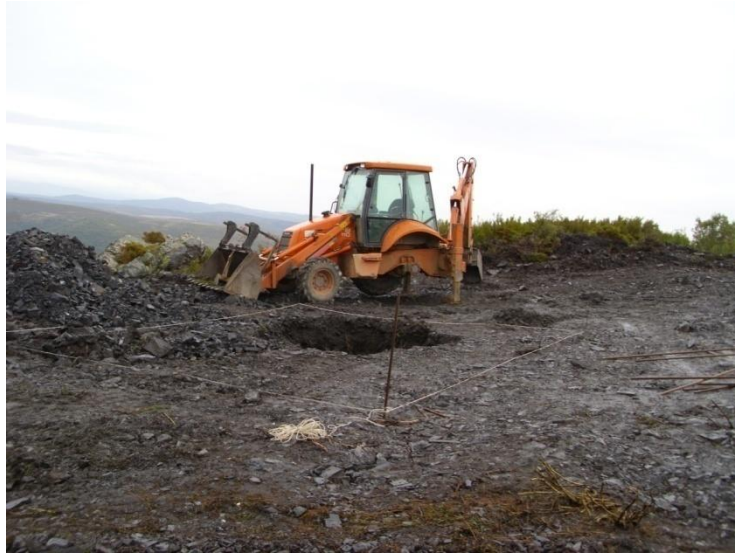
Figura 2.3 – Início da realização de fundação para inserção da torre e construção da laje
