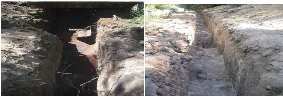
Figuras 5.20 e 5.21 – Colocação do eléctrodo de cobre em vala
