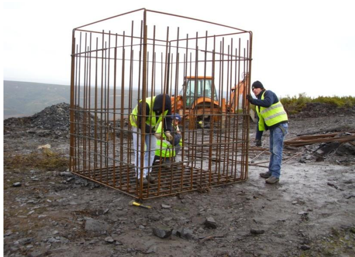
Figura 2.4 – Armação que será inserida na fundação
