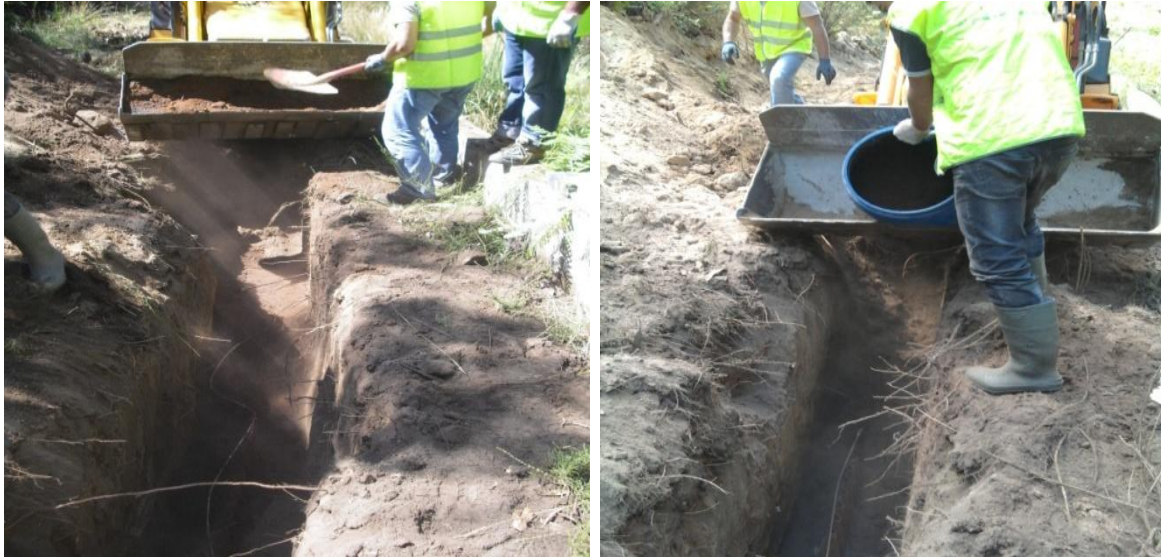
Figuras 5.26 e 5.27 – Colocação da mistura de carvão e terra vegetal
