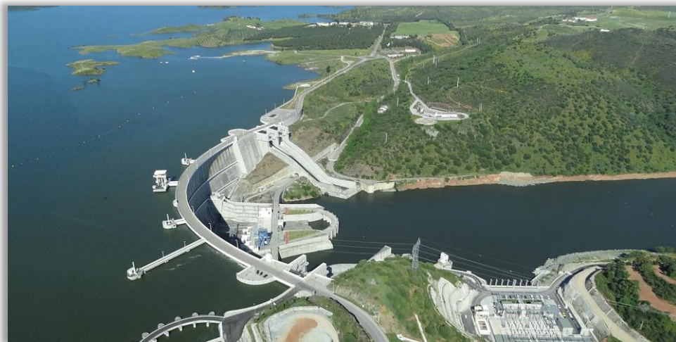
Figura 7: Exemplo de circuito aberto – Barragem do Alqueva (Fonte: A Terceira Dimensão)
