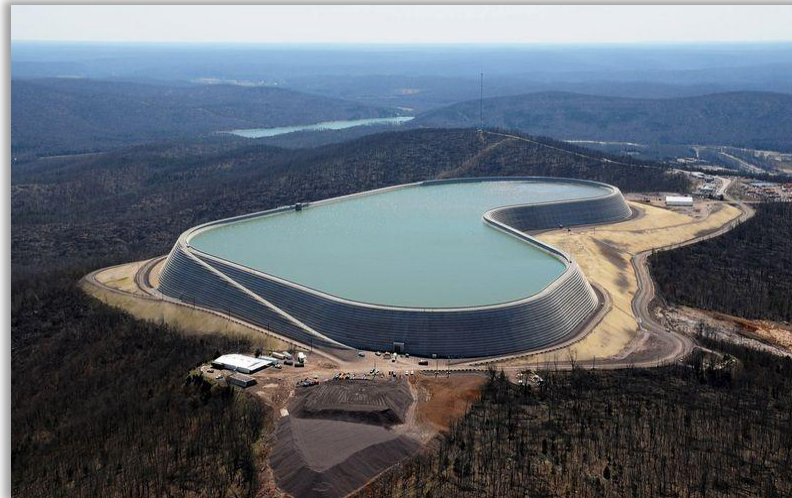
Figura 1: Reservatório Taum Sauk (Fonte: Industcards)
