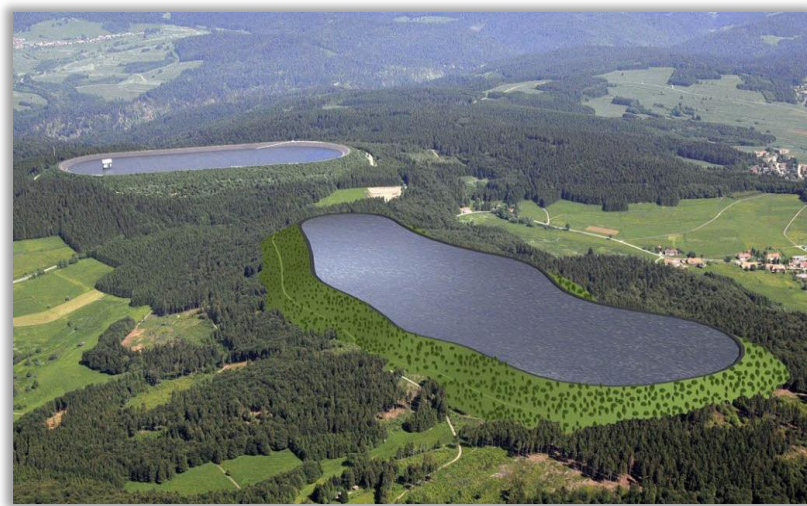
Figura 2: Vista sobre o reservatório existente Hornberg I e ilustração do reservatório Hornberg II (Fonte: Freiburg-Schwarzwald)
