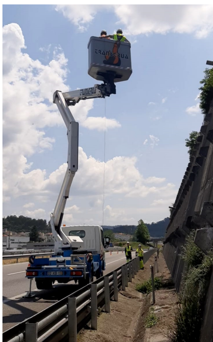
Figura 26 - Condições de acesso para inspeção do muro M02.
