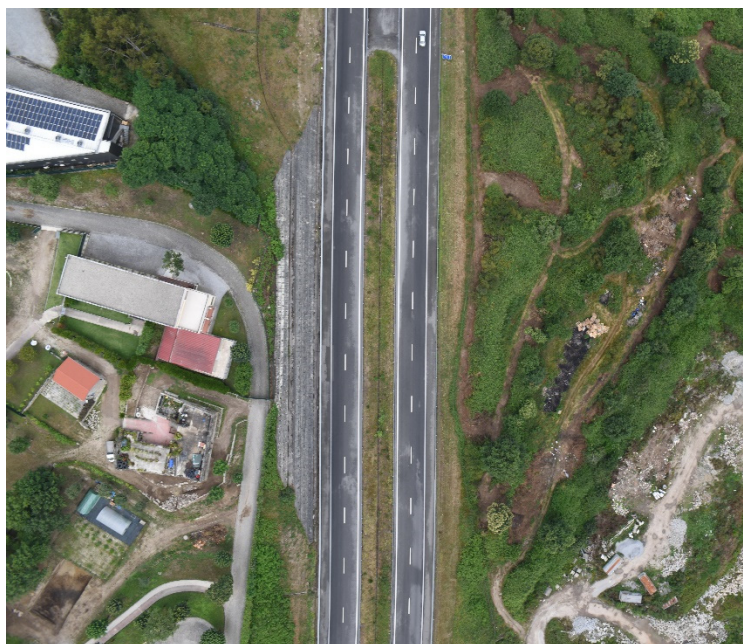
Figura 23 - Fotografia aérea do muro M02 (Ascendi, 2021).
