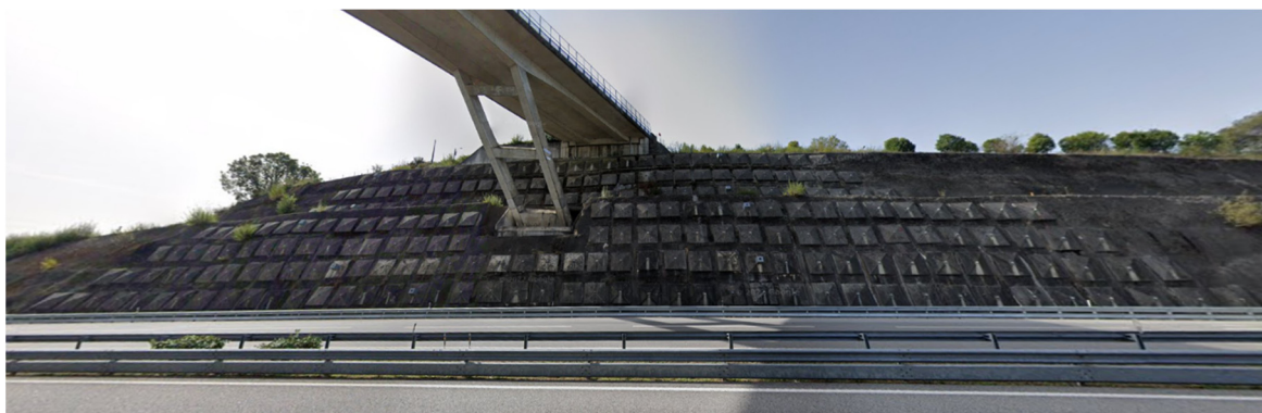
Figura 28 - Perspetiva do muro ancorado M07.
