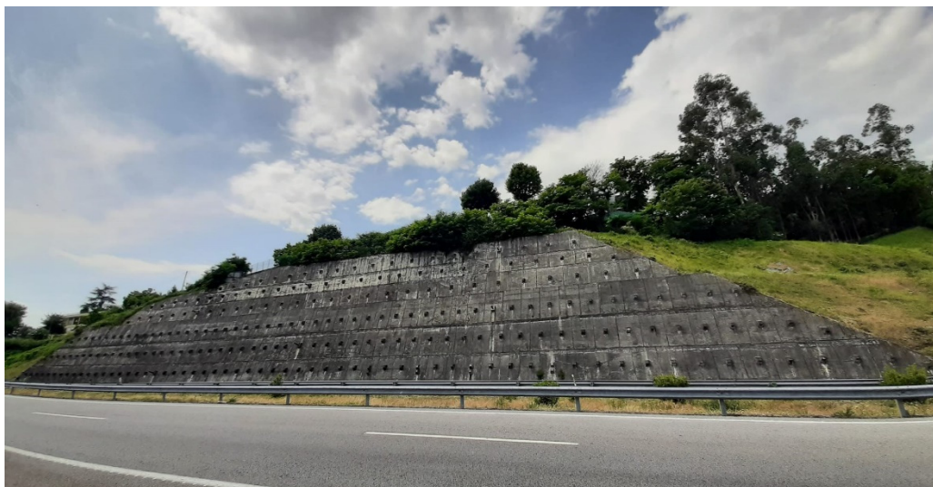
Figura 22 - Perspetiva do muro ancorado M02.
