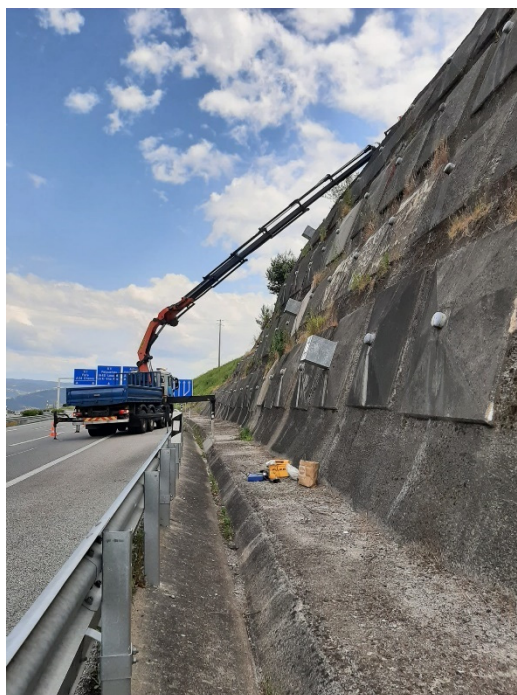
Figura 32 - Condições de acesso para inspeção do muro M07.
