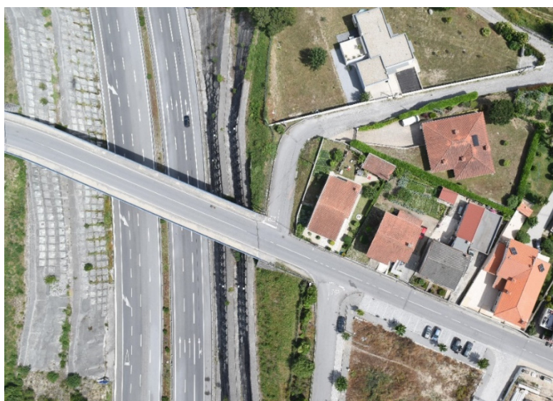
Figura 29 - Fotografia aérea do muro M07 (Ascendi, 2022).
