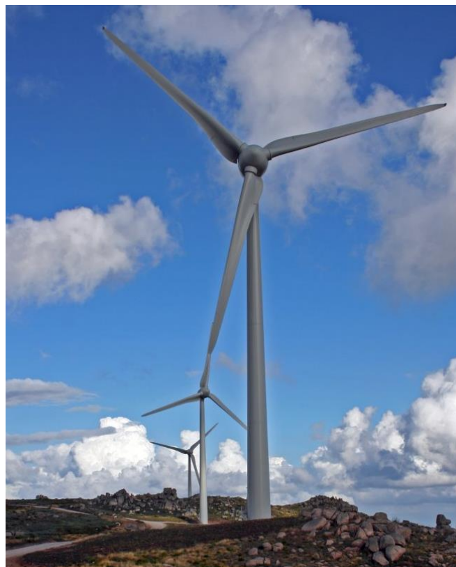
Figura 16 – Aero gerador síncrono, parque eólico do Caramulo, ENERCON E70/E4.
