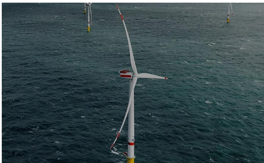
Figura 2 – Aerogerador Vestas V164 10 MW.
