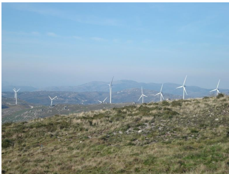
Figura 13 – Aerogerador indução DA, parque eólico de Fafe, Gamesa G87.
