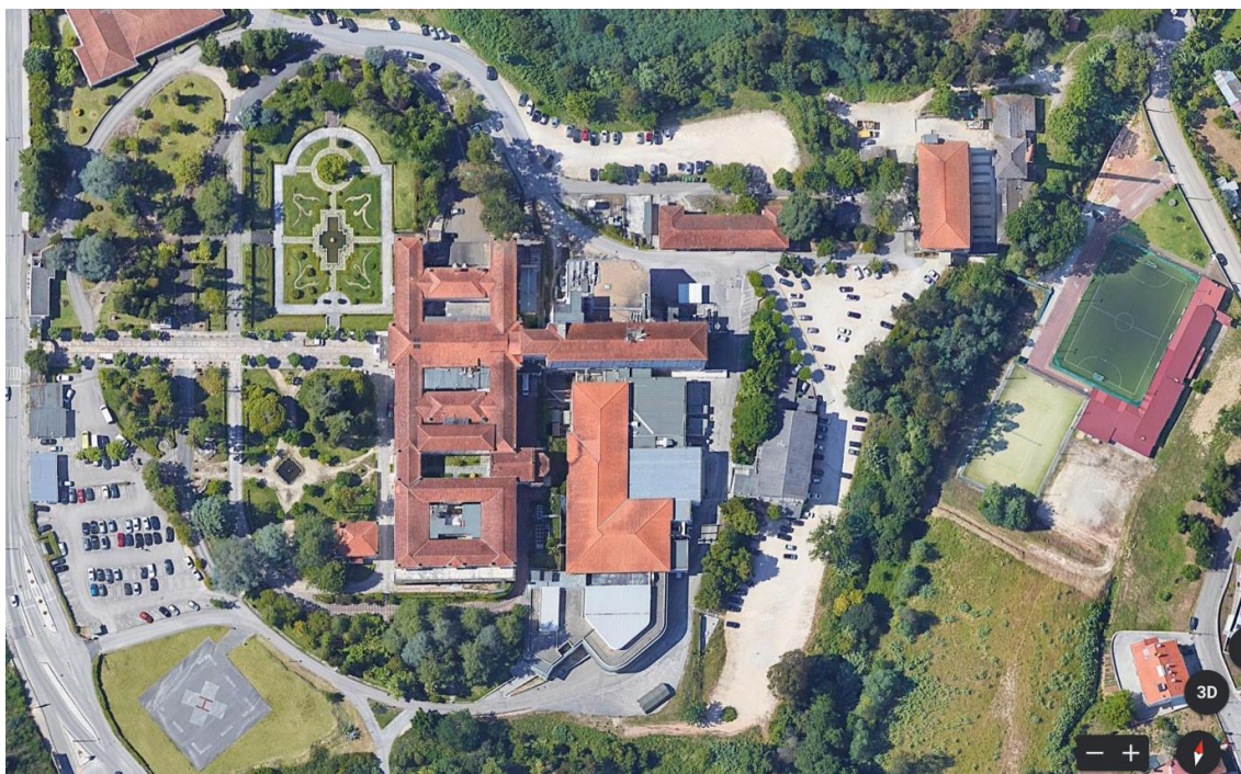
Figura 5: Fotografia aérea do Hospital dos Covões, obtida a partir do Google Earth.
