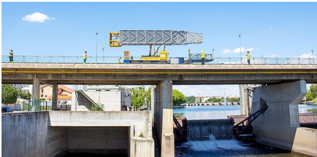
Figura 30 – Plataforma móvel para inspeção a uma ponte em Mirandela. (Alves, 2019)
