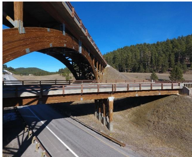
Figura 47 – Vista geral da ponte. (Duque, 2017)
