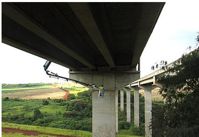
Figura 31 – Inspeção de uma ponte. (Timepress Comunicação Empresarial, 2019)
