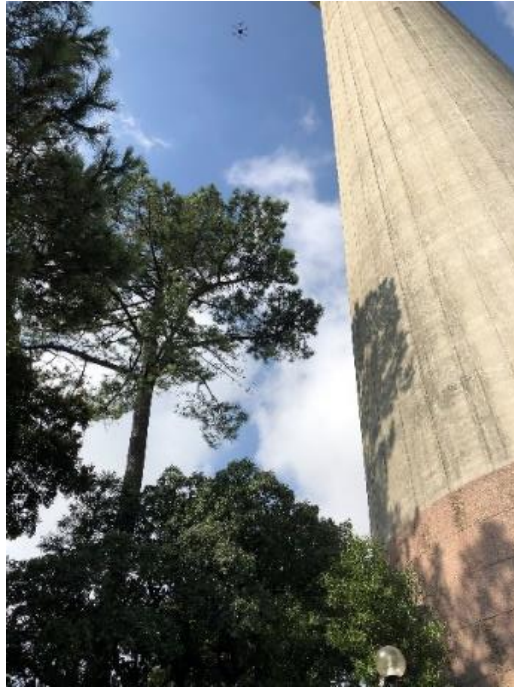
Figura 106 – Árvores junto ao fuste de betão da torre.
