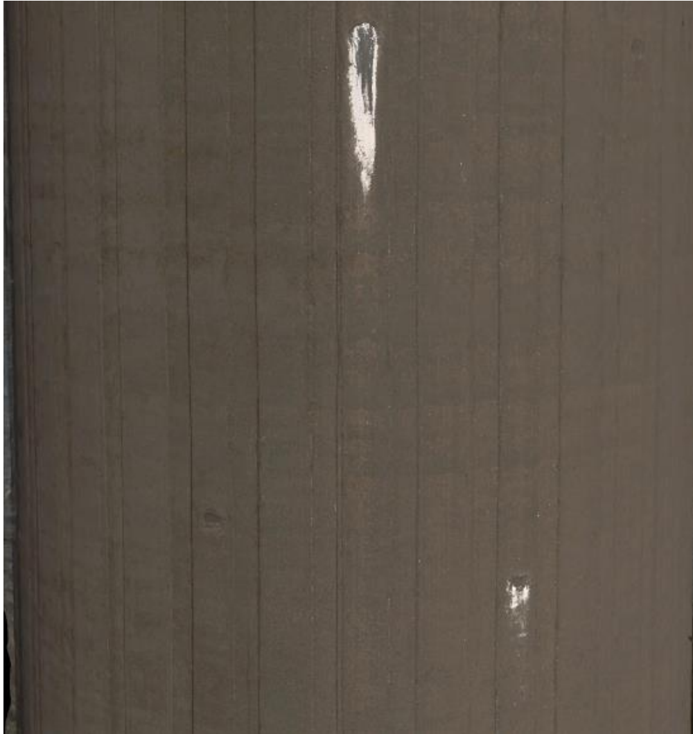
Figura 140 – Resultado da modelação 3D das imagens processadas de deteção de eflorescências.
