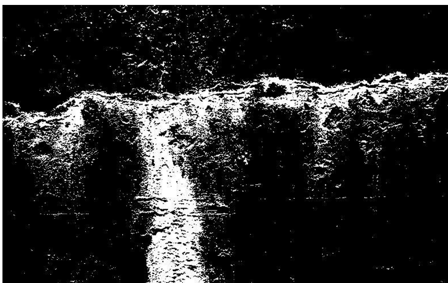
Figura 91 – Exemplo de Aplicação 1 (Eflorescências) – Imagem Processada.
