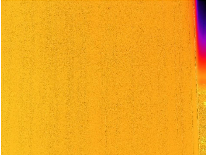
Figura 113 – Imagem térmica do fuste de betão.
