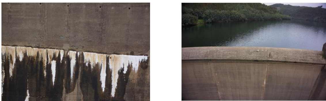
Figura 34 – Captação de imagens com recurso a VANT na barragem de Bouçã. (Henriques, et al., 2015)
