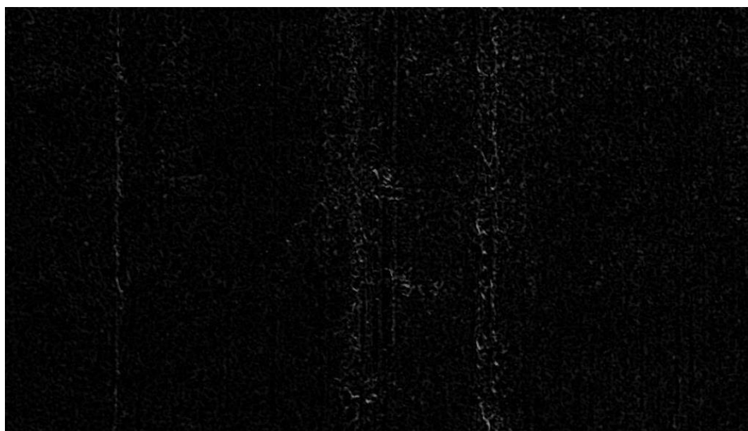
Figura 125 – Detecção das irregularidades da superfície do fuste de betão.
