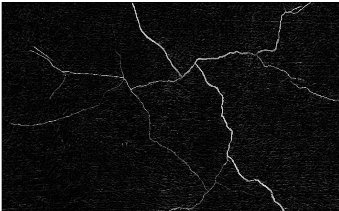
Figura 77 – Exemplo de Aplicação 1 (Fissuras) – Imagem Processada.
