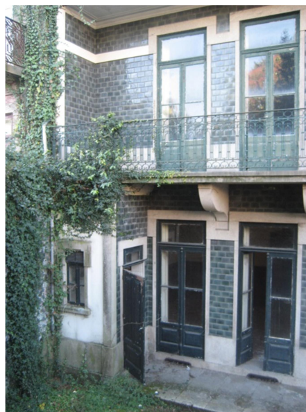
Figura 3.12 - Parede de fachada traseiras
