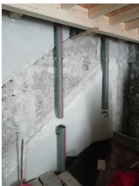
Figura 3.41 - Alinhamento da tubagem de drenagem de águas
