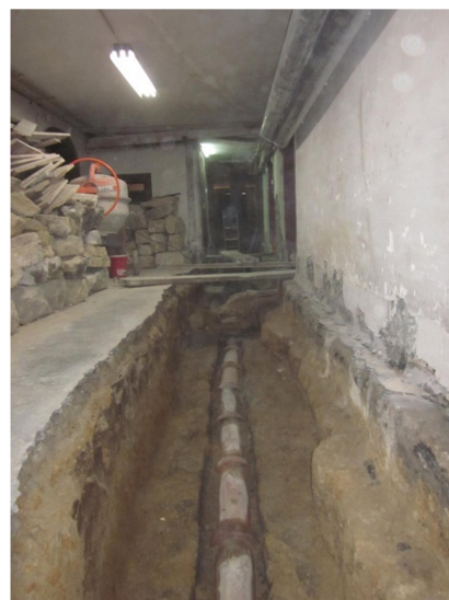
Figura 3.37 - Colocação tubos drenantes
