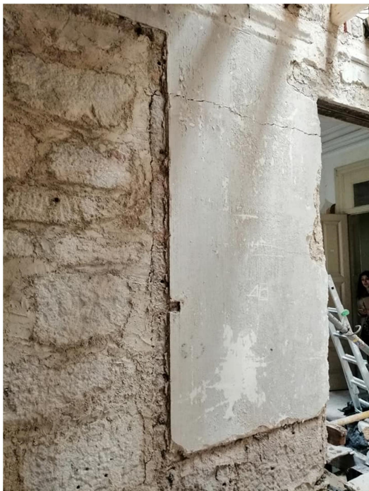
Figura 3.13 - Parede interior em alvenaria de pedra
