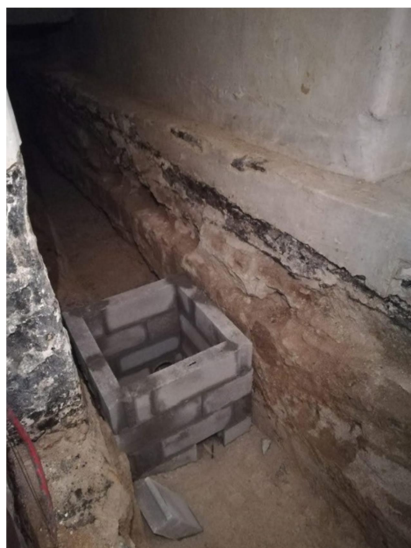
Figura 3.36 - Execução de caixa na área técnica
