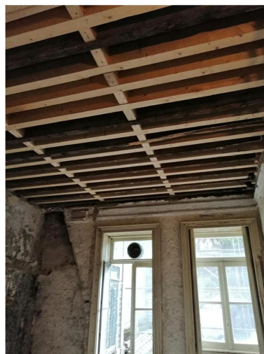
Figura 3.52 - Pavimento piso 1 orientação Este do edifício
