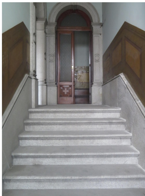
Figura 3.18 - Escadas em pedra da entrada do edifício
