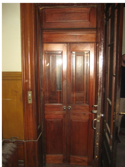
Figura 3.22 - Porta interior em madeira
