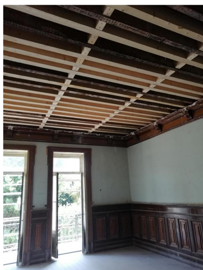
Figura 3.53 – Reforço finalizado piso 2
