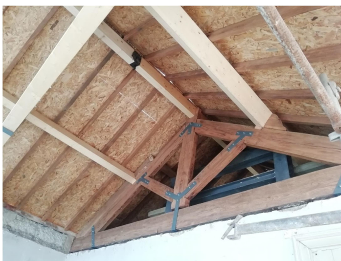
Figura 4.16 - Estrutura da cobertura finalizada
