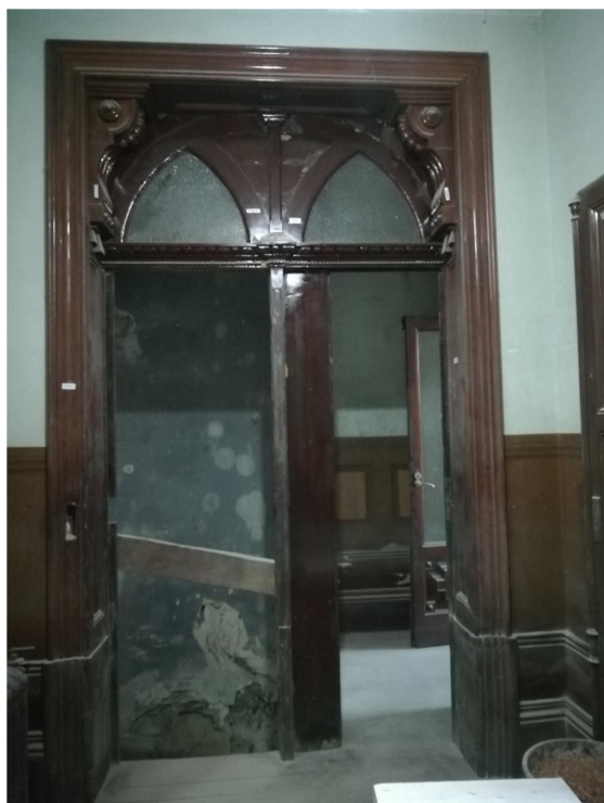
Figura 3.46 - Porta interior da zona comum
