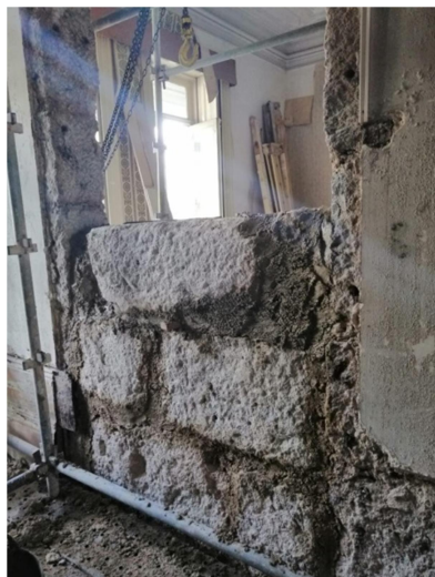
Figura 3.59 - Processo de colocação de alvenaria de pedra
