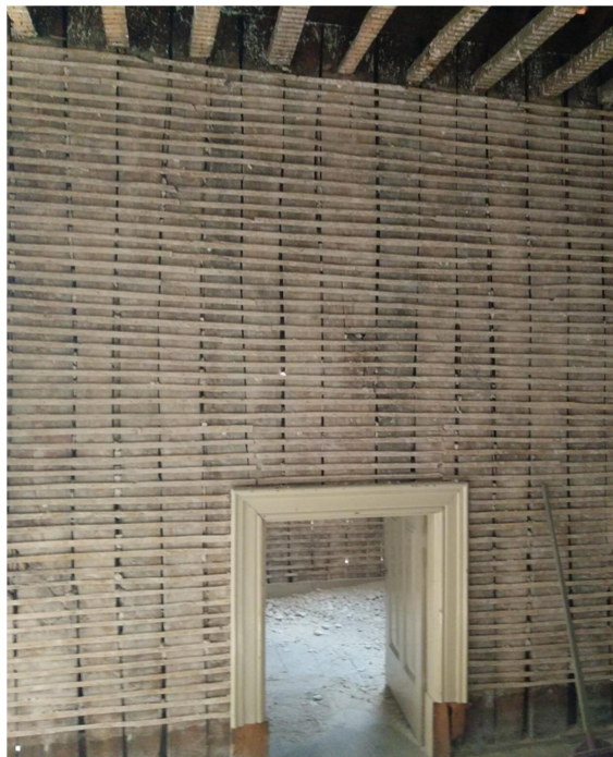
Figura 3.14 - Parede de tabique no último piso
