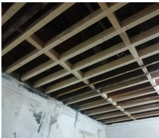
Figura 3.55 - Reforço de vigas no piso 3
