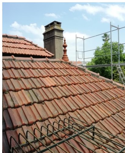
Figura 3.10 - Vista exterior da cobertura
