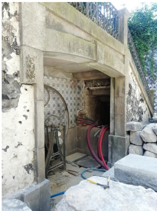
Figura 3.38 – Abertura para passagem de infraestruturas
