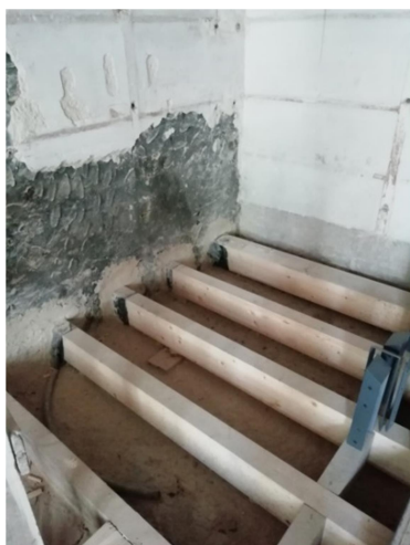
Figura 3.49 - Pavimento piso 0 na zona do mezanine
