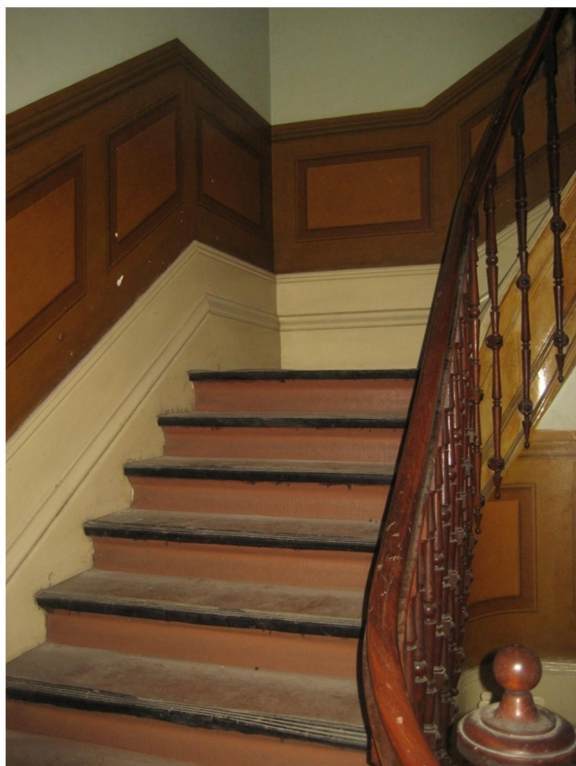
Figura 3.17 - Escadas centrais em madeira
