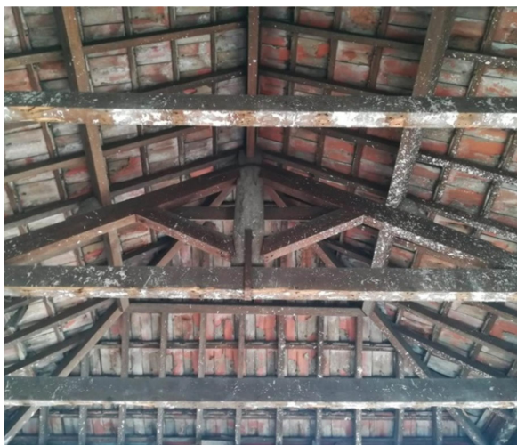
Figura 3.9 - Estrutura da cobertura
