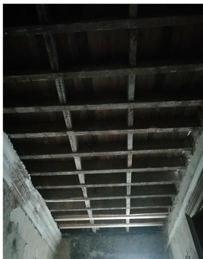
Figura 3.51 – Pavimento piso 1 orientação Oeste do edifício
