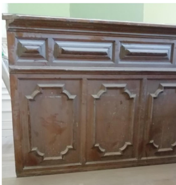
Figura 3.43 - Lambrim original removido da parede
