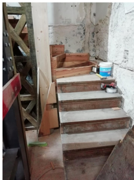
Figura 4.13 - Montagem degraus escada
