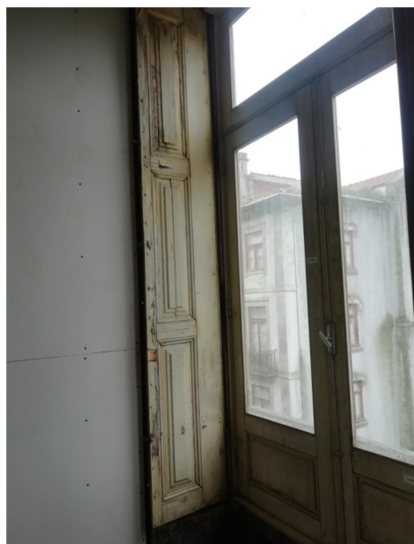
Figura 3.19 - Caixilharia de janela de batente fachada principal
