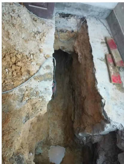
Figura 3.35 - Escavação para colocação tubos drenantes
