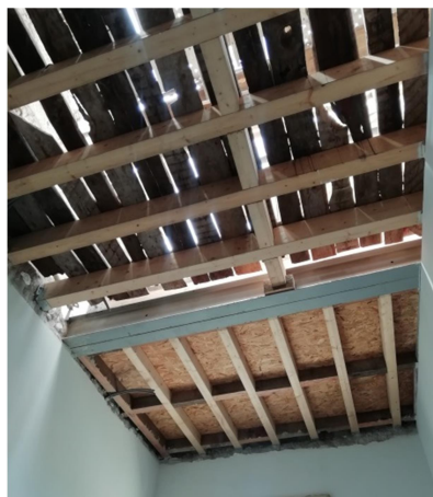
Figura 3.56 - Reforço pavimento piso 3 na zona de ampliação da cobertura
