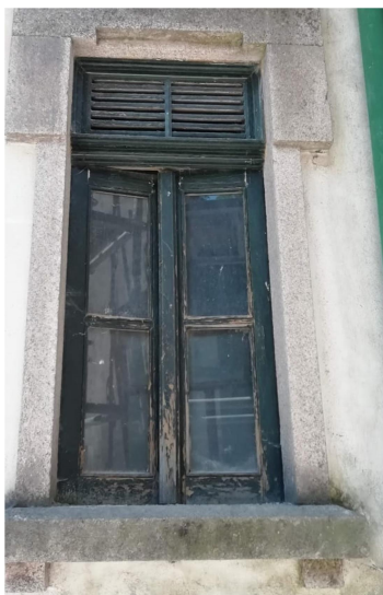
Figura 3.20 - Caixilharia de janela de batente fachada posterior
