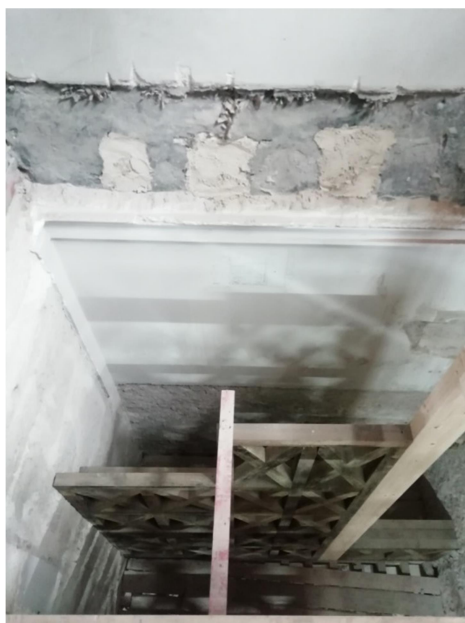
Figura 4.12 - Montagem das paredes frontais
