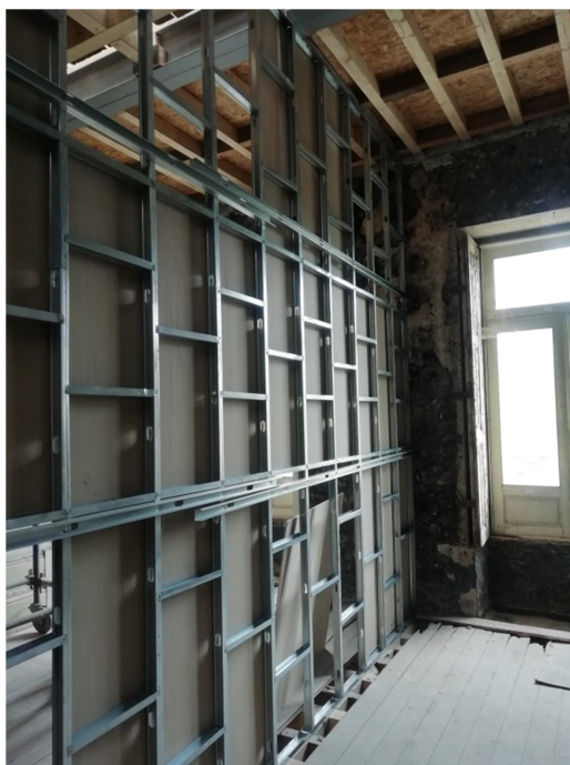
Figura 3.39 - Estrutura de paredes divisórias em perfis metálicos no apartamento 9
