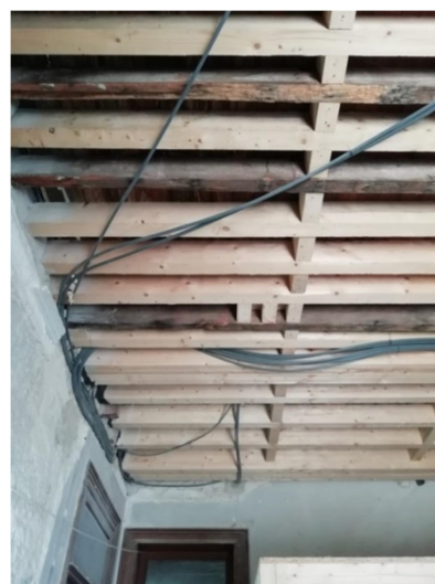
Figura 3.54 – Reforço no pavimento piso 2
