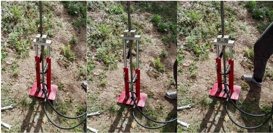
Figura 7 - Extração das varas recorrendo a equipamento apropriado
