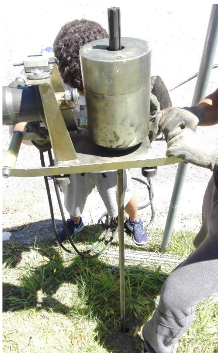
Figura 5 – Início da cravação da vara através de sucessivos golpes originados pelo pilão
