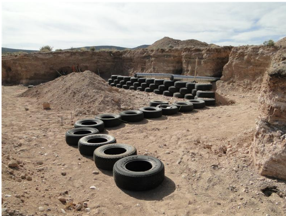
Figura 4 - Cincinnati House (construção do muro de pneus) (Fonte: http://www.offthegridbuild.com )
