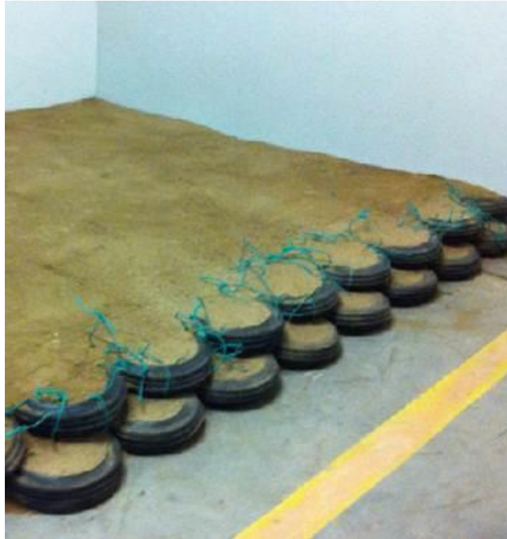
Figura 63 – 4ª Fase do faseamento construtivo do muro
