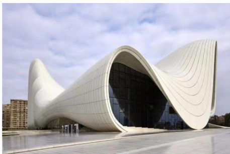
Figura 9- Painéis em fibra de vidro como revestimento de edifício [12]
