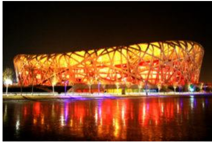
Figura 20- Estrutura de estádio produzida em compósito polimérico de matriz termoplástica [26]
