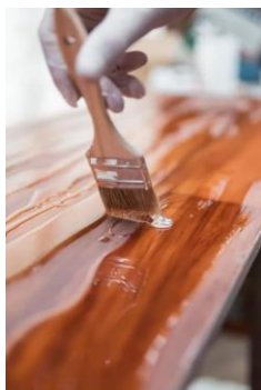
Figura 24- Exemplo de aplicação de resina epóxi em madeiras [32]
