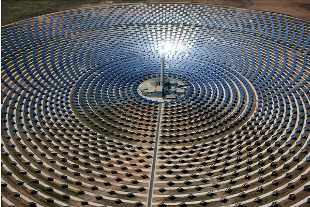
Figura 18 - Exemplo de central de potência concentrada (Limited, 2023)
