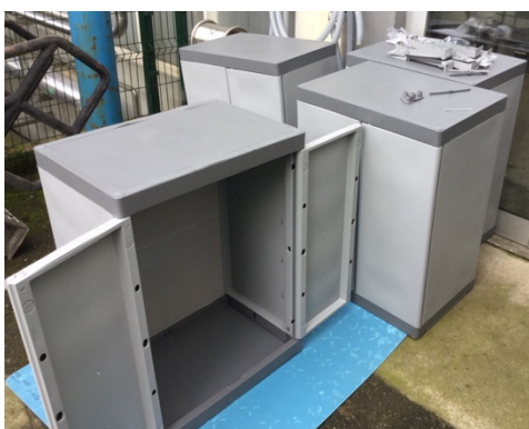
Figura 58 – Montagem dos armários para kits de derrame.
