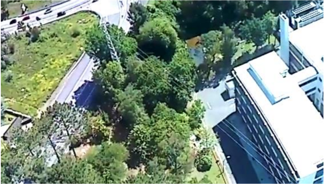
Figura 53: Inspeção a torres
