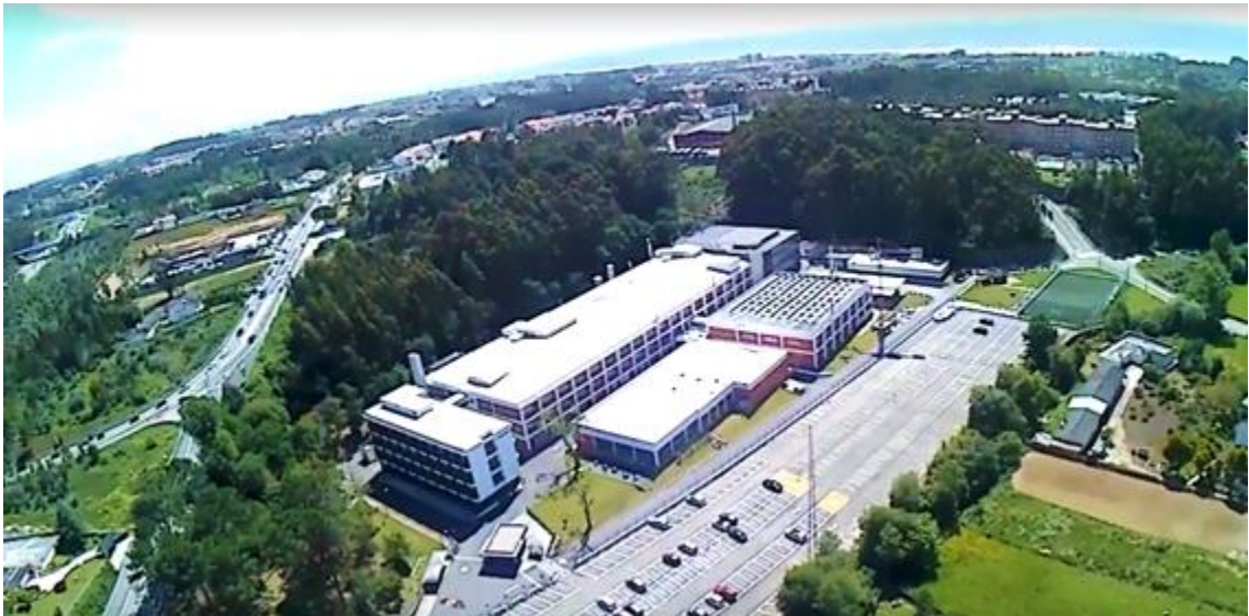
Figura 51: Inspeção de infra-estruturas
