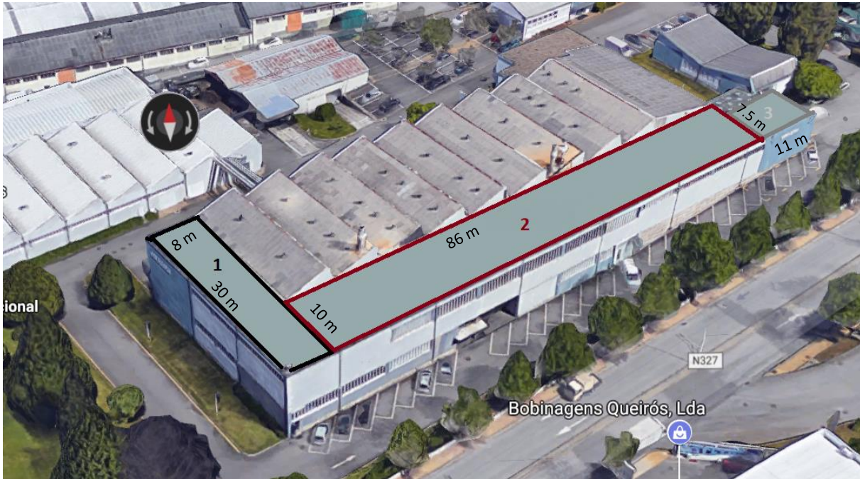
Figura 6.3- Área de cobertura disponível para a instalação do sistema fotovoltaico [35]
