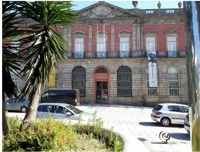
Figura 21. Entrada sem degraus, MNSR.
