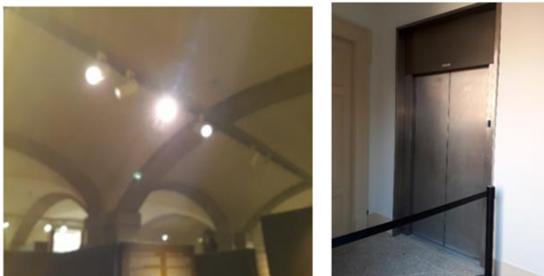
Figura 75. Iluminação automática e o elevador, MNSR.
