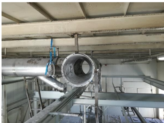
Figura A. 53 - Bifurcação da linha principal após a limpeza, na perspectiva do ramal LS10A
