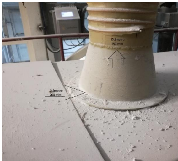
Figura A. 35 - Captação LS5, no transportador de banda de açúcar especial para Máquina Libra (TRBA 0167)
