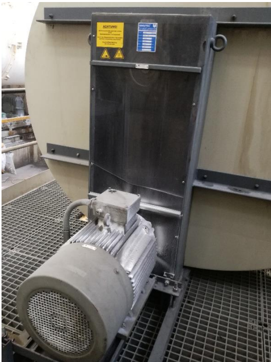
Figura A. 63 - Caixa de proteção do sistema de transmissão do motoventilador
