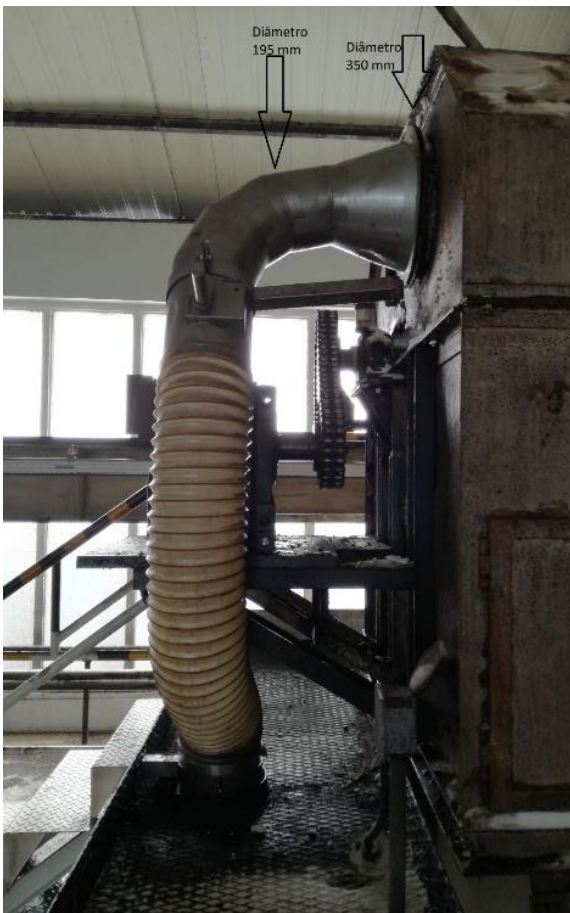
Figura A. 43 - Captação LS10A3, no elevador de retorno dos classificadores (LS10A3)
