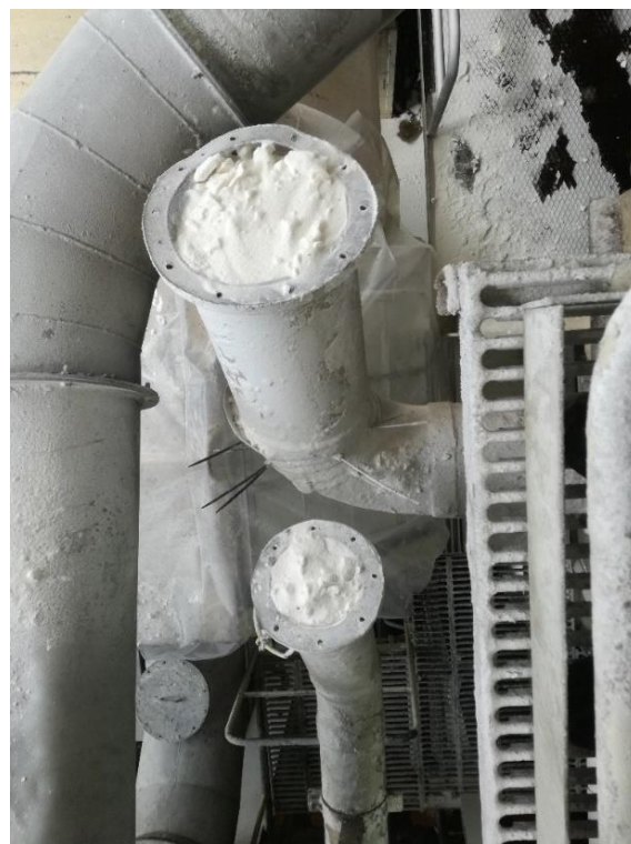
Figura A. 49 - Interior das condutas dos ramais LS3 e LS4
