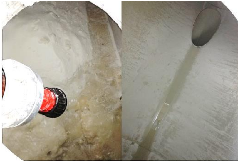
Figura 3.13 - Comparação do estado inicial (esquerda) com o estado final da conduta (direita) após a limpeza
