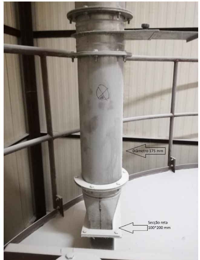
Figura A. 41 - Captação LS10A1, no silo de 40 ton de açúcar a granel (SILO 0031)
