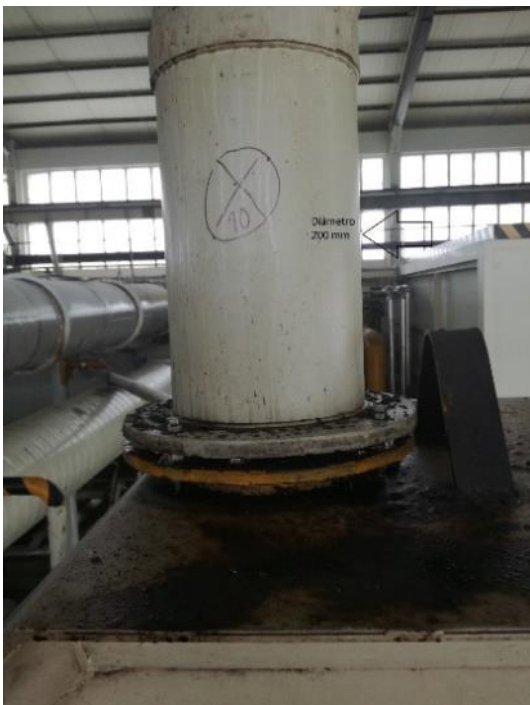
Figura A. 30 - Captação LS2A, no elevador de açúcar para silo de 70 ton (ELVE 0013)
