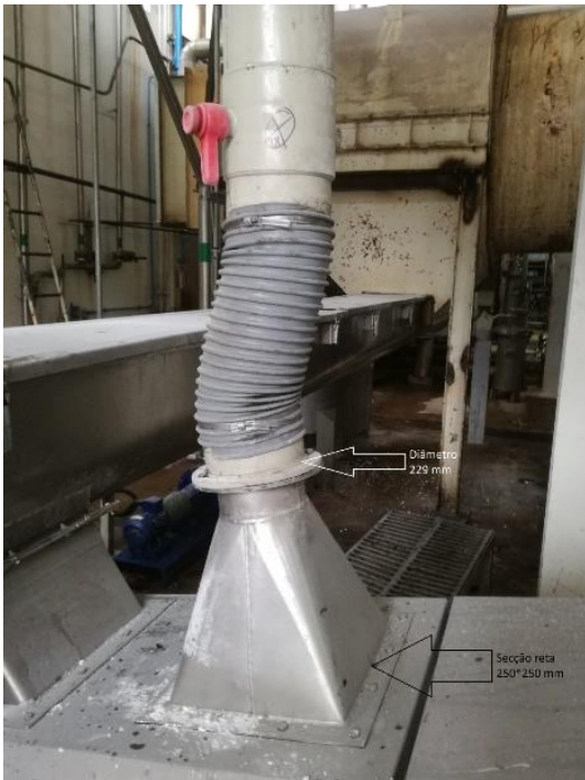
Figura A. 29 – Captação LS1, na base do transportador de bandas de ligação ao sem-fim de descarga secador 20 ton (TRBA 0163)
