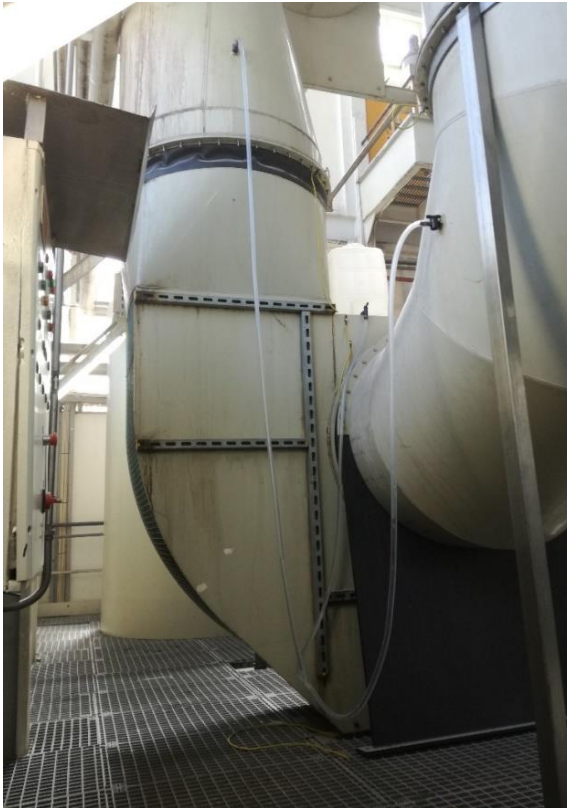
Figura A. 61 - Instalação experimental para determinação da queda de pressão no ventilador
