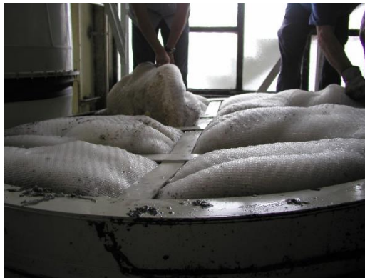
Figura A. 58 - Instalação de novo filtro
