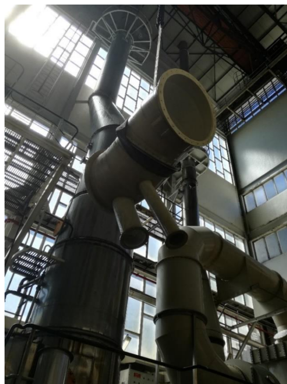
Figura A. 50 - Ligação entre os ramais LS3 e LS4 e a conduta principal, após limpeza
