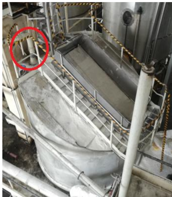
Figura A. 3 – Silo de 70 ton (SILO 0031)
