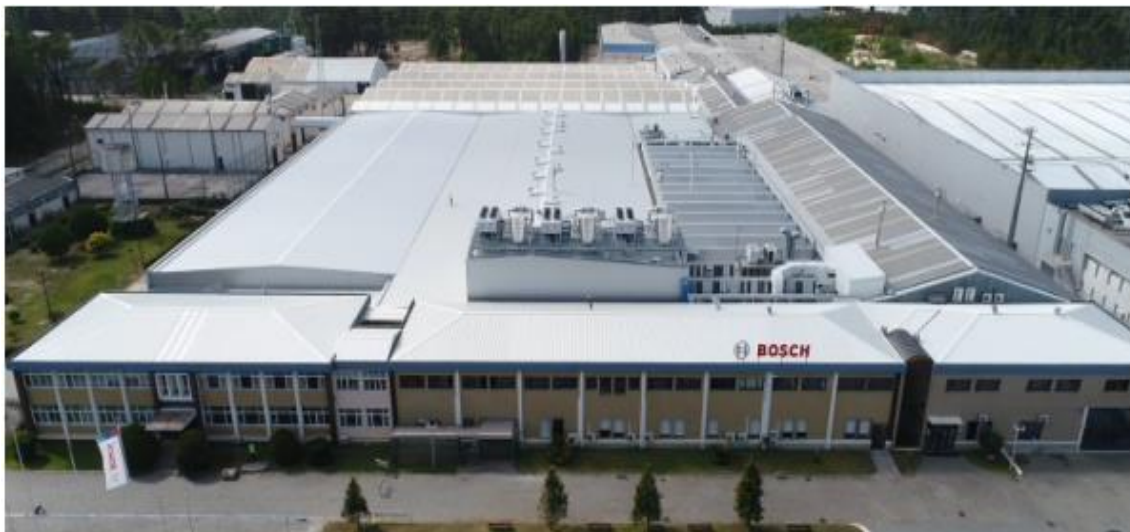
Figura 2 - Instalação da Bosch Security and Safety System, S.A. (Bosch Portal, 2020)
