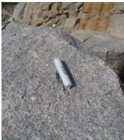
Figura 5 – Colocação do explosivo sobre o bloco.
