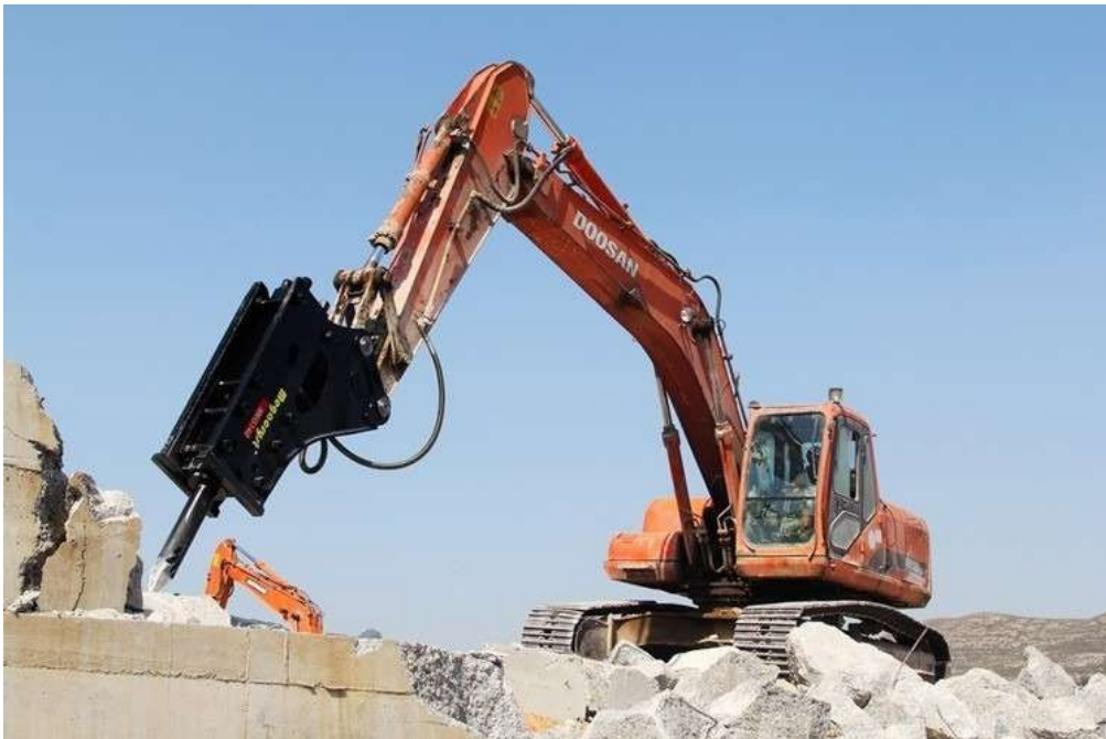
Figura 7 – Fragmentação secundária através do martelo demolidor (fonte: https://http2.mlstatic.com/martelo-hidraulico-novo-rompedor-para-retroscavadeira ).
