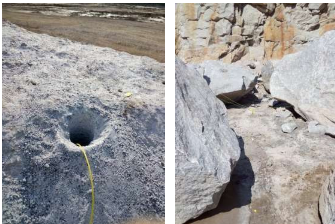
Figura 6 – Colocação do explosivo dentro do furo executado no bloco.
