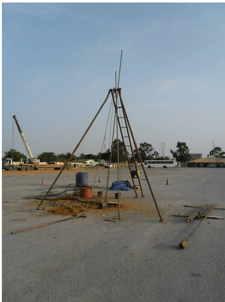
Figura.7 Sonda SPT à percussão.
