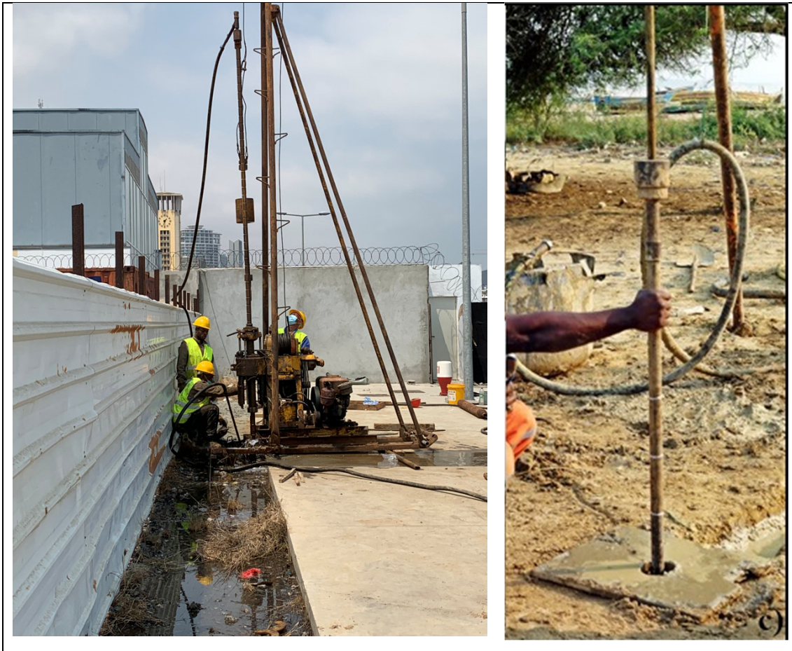
Figura.12 Realização dos ensaios de SPT.
