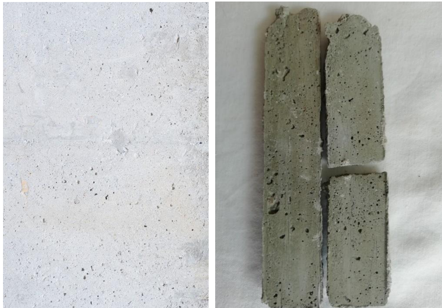
Figura 6.1 – À esquerda: betão cofrado com painel metálico e à direita: aspecto final da argamassa cofrado com perfil compósito [Fonte: o autor]
