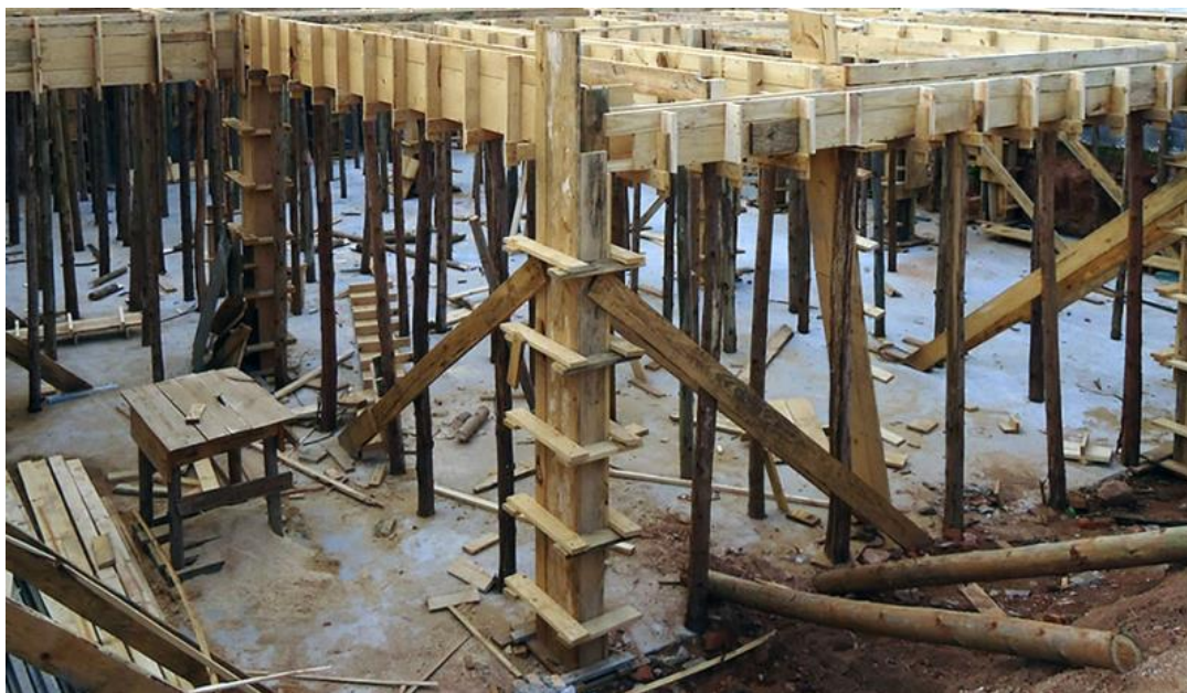
Figura 2.1 - Cofragem Tradicional e a Utilização de Madeira [8]
