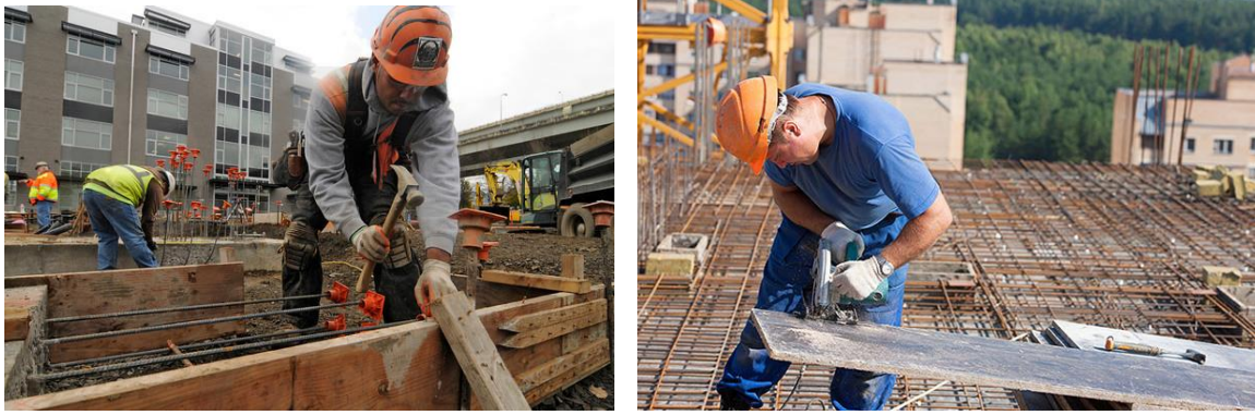
Figura 2.3 - Carpinteiros a trabalhar nos moldes tradicionais em madeira [9]
