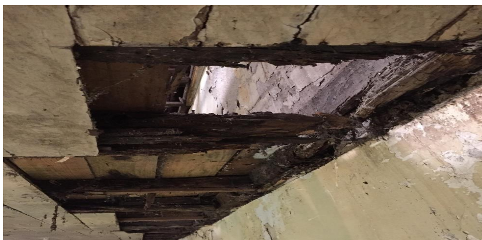
Figura 3.40 – Viga da estrutura do pavimento.
