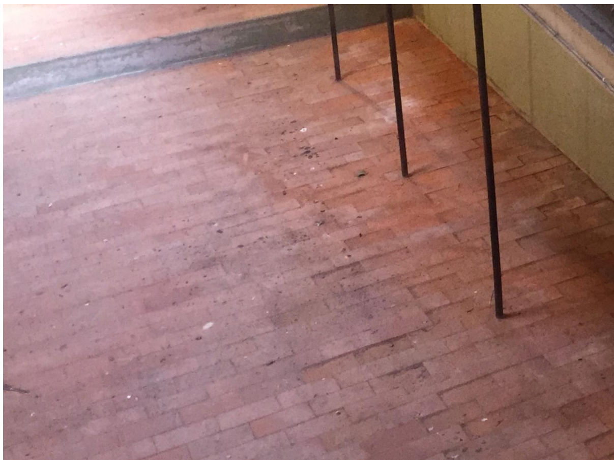
Figura 3.31 – Revestimento do pavimento da plateia.
