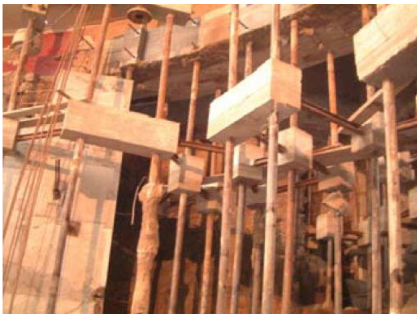
Figura 2.27 – Maciços de travamento das microestacas [10].
