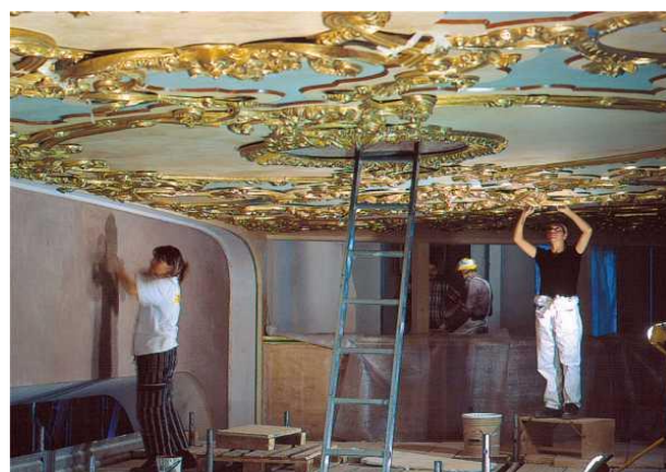
d) Restauro de tetos e paredes.
