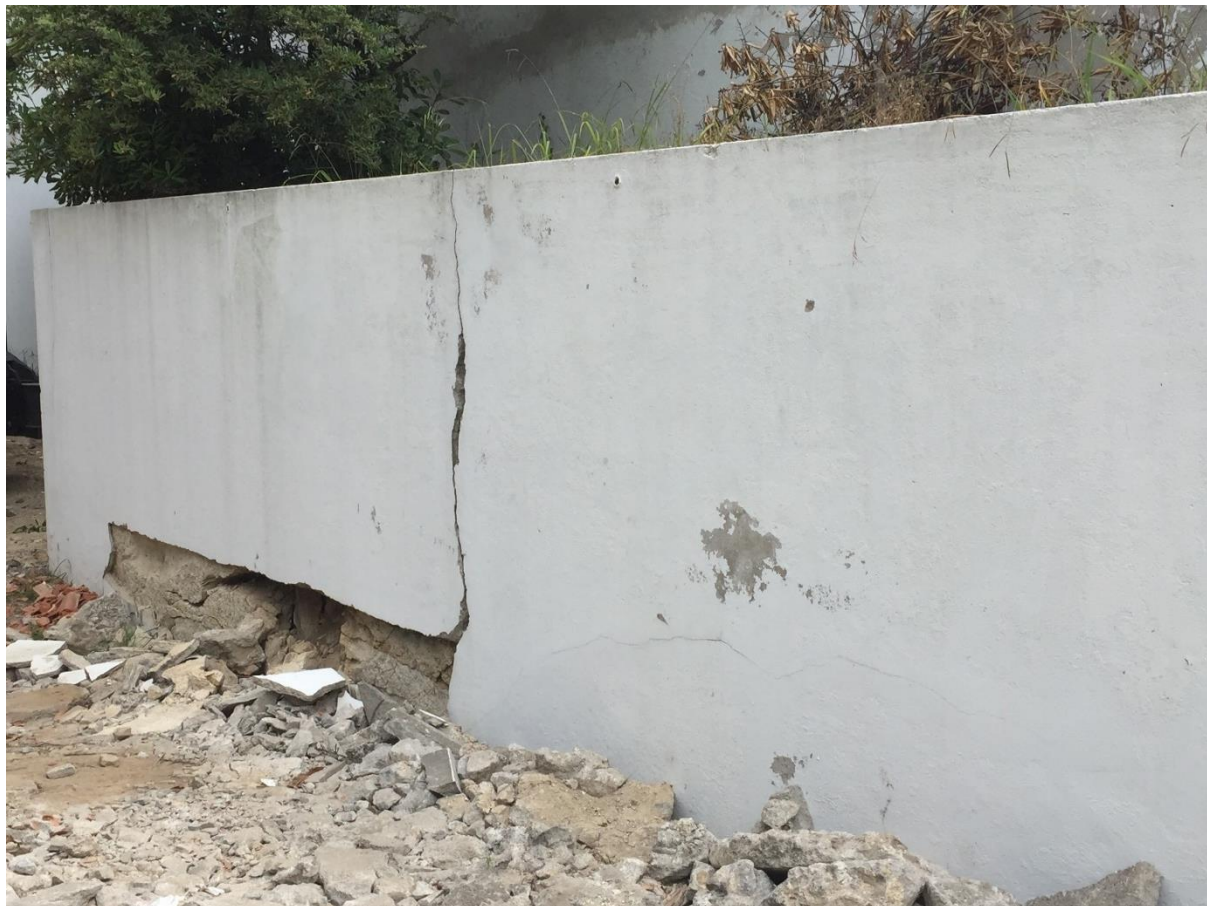
Figura 5.13 – Muro exterior existente.
