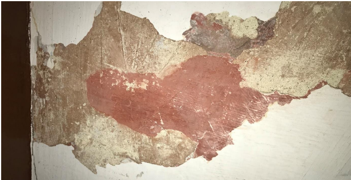
Figura 3.47 – Sondagem às pinturas.
