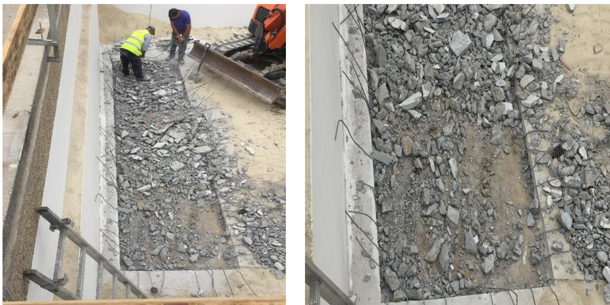
Figura 5.11 – Execução de trabalhos de demolição, de parte da laje da piscina.
