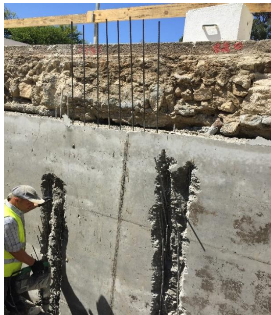
Figura 5.10 – Abertura de roços para colocação da armadura em espera.
