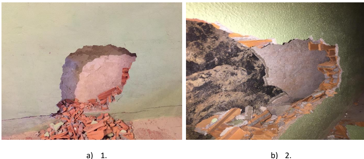
Figura 3.42 – Paredes interiores de alvenaria de granito do edifício.
