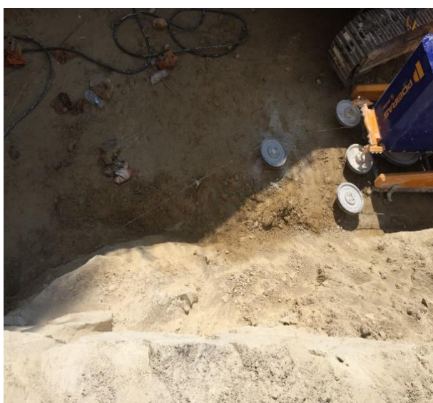
c) Execução do corte.
