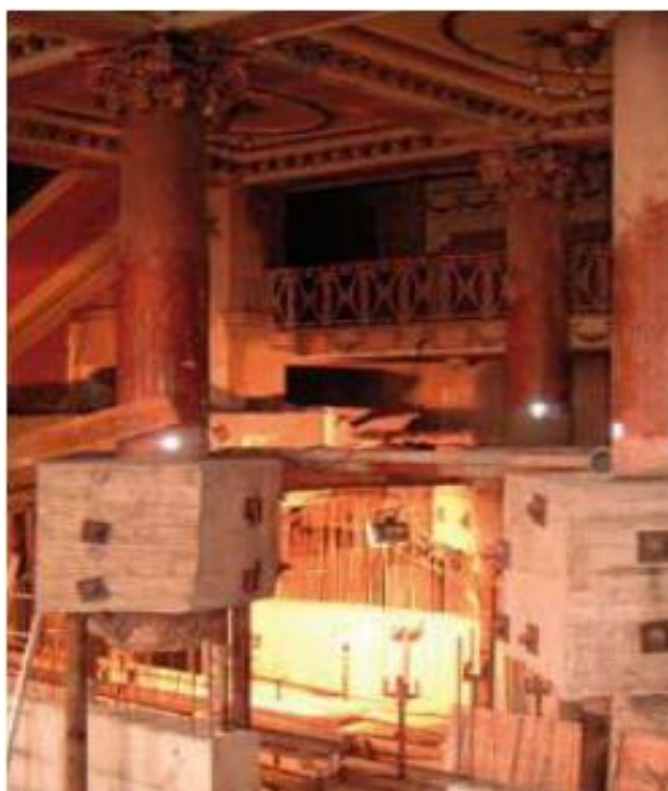
Figura 2.26 – Maciços de recalçamento dos pilares e encabeçamento das microestacas [20].
