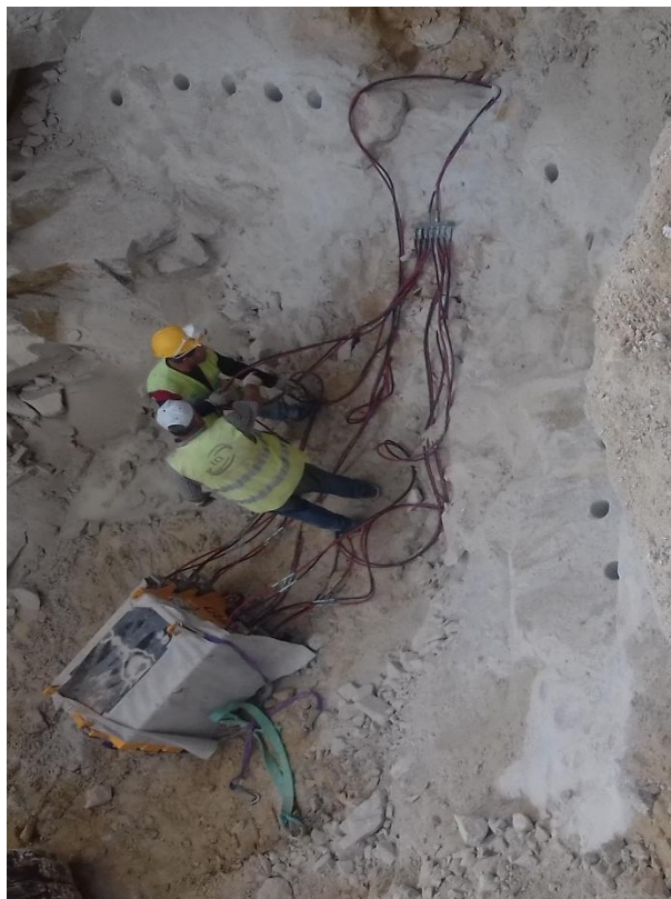
b) Colocação de expansores nos furos.
