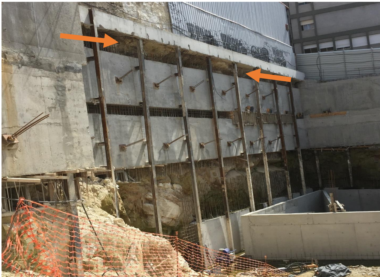
Figura 4.12 – Pormenor muro tipo Berlim definitivo.
