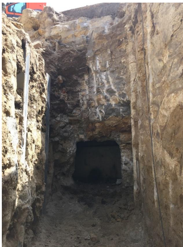
Figura 5.3 – Galeria de acesso à arrecadação.
