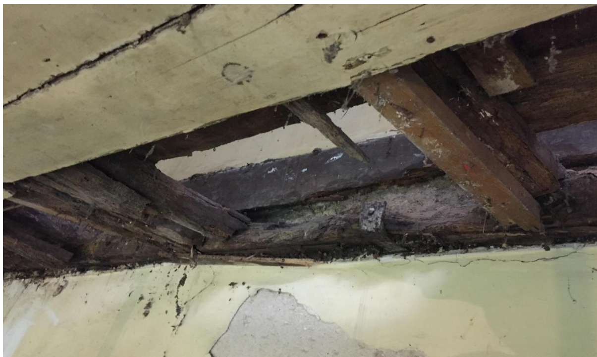
Figura 2.24 – Ligação do pavimento à parede, através do frechal.
