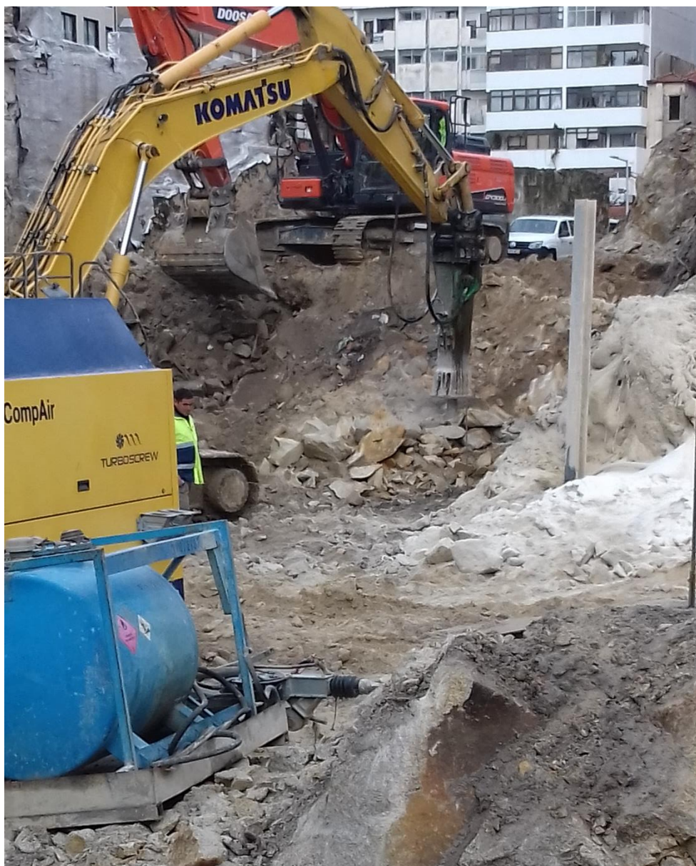
Figura 4.13 – Desmorte da pedra com recurso ao martelo saneador.
