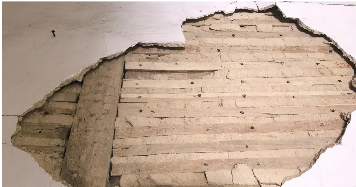
Figura 3.35 – Parede em tabique.
