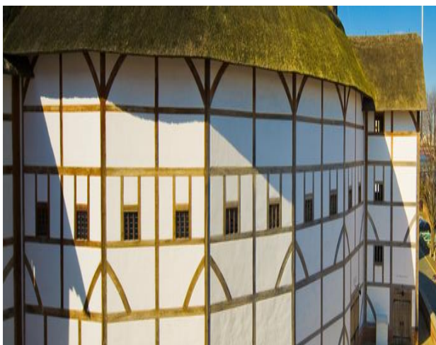
a) Vista exterior [55].
