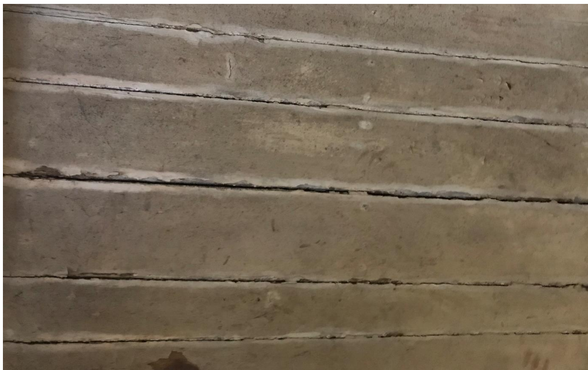
Figura 3.33 – Revestimento de teto em sistema de encaixe macho-fêmea
