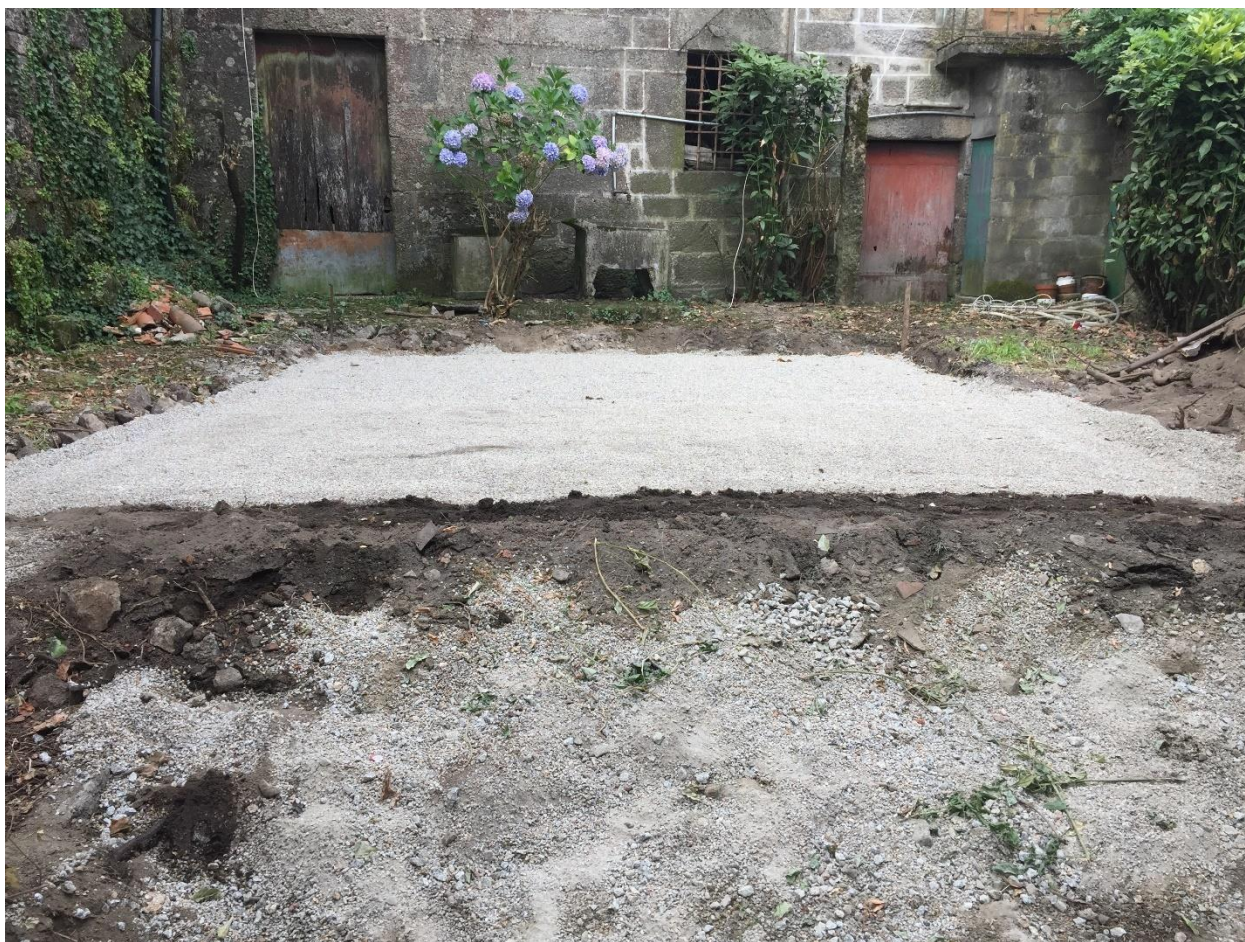
Figura 3.37 – Base de assentamento, para receber a grua.
