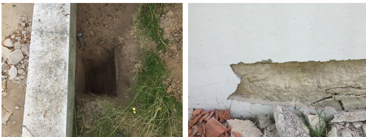
Figura 5.14 – Trabalhos de prospeção.
