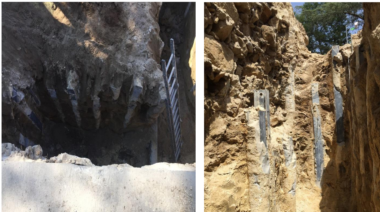
Figura 5.4 – Microestacas.
