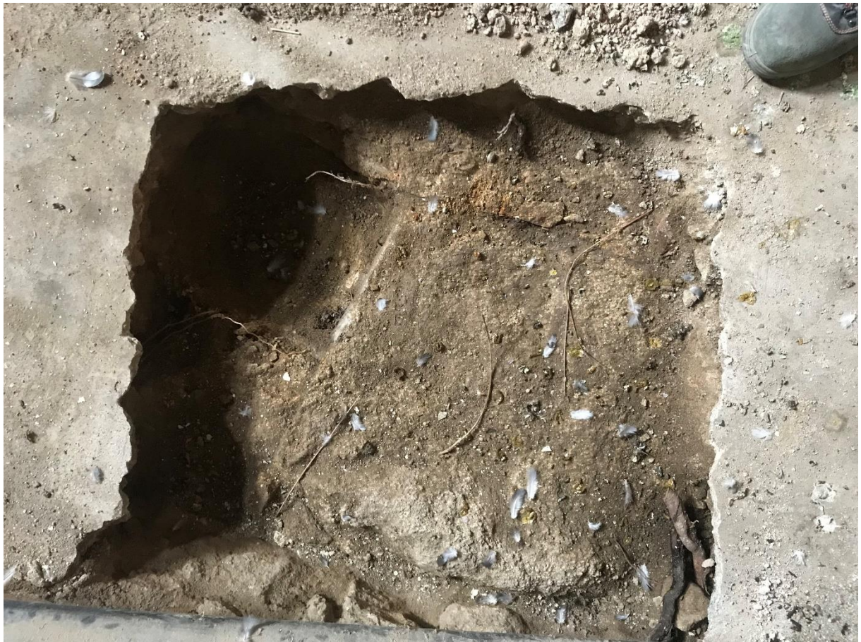
Figura 3.49 – Prospeção geológico-geotécnica ao terreno de fundação.
