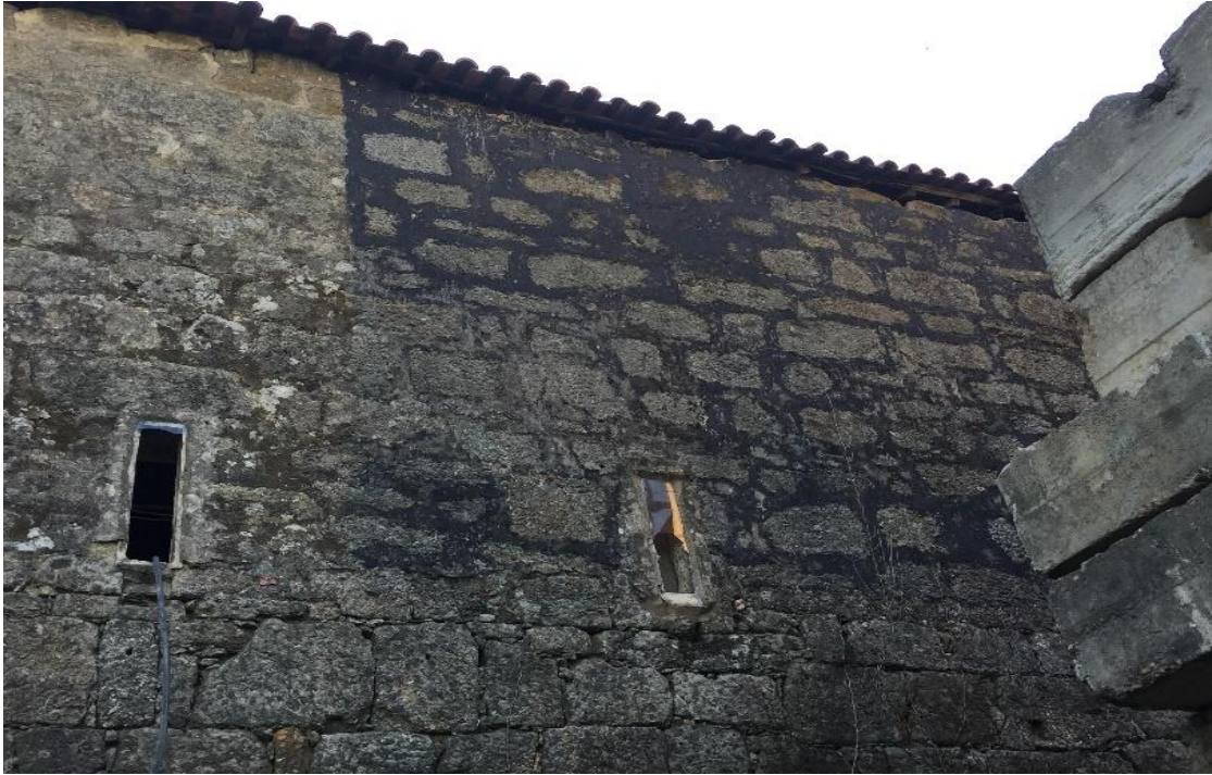
Figura 3.44 - Face exterior da Parede 1.
