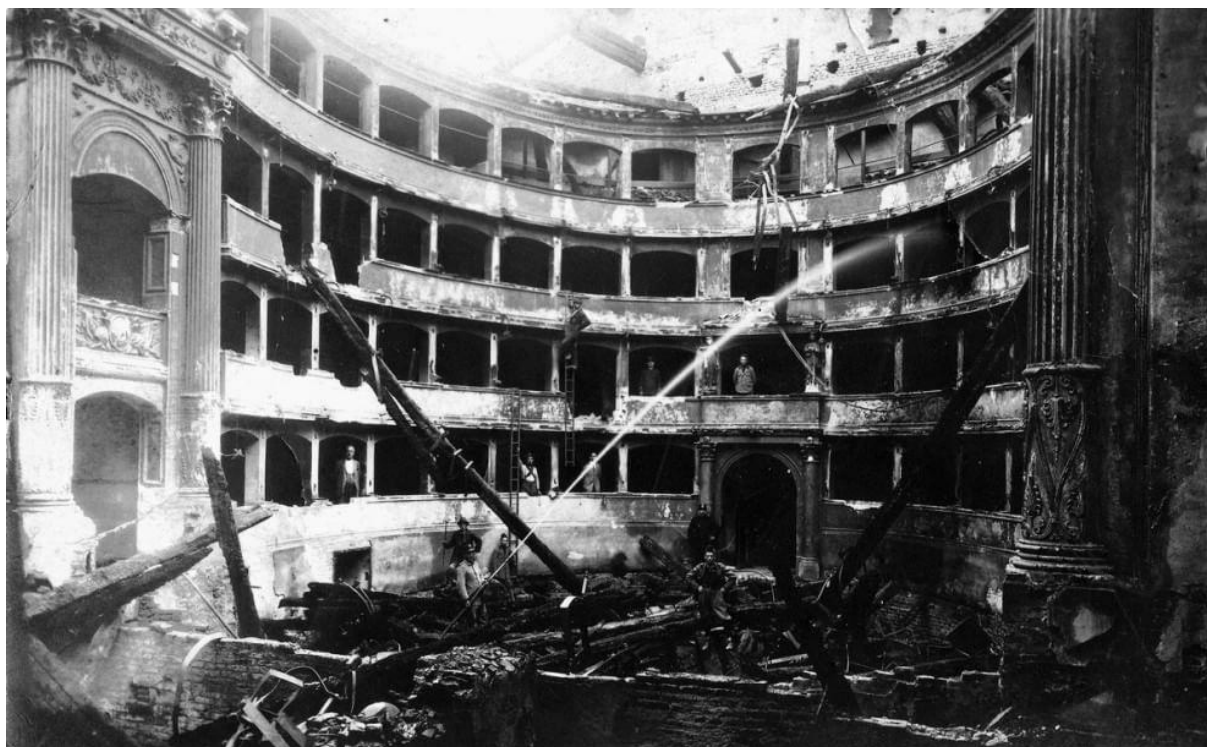
Figura 2.8 – Situação do edifício, após o bombardeamento da segunda guerra mundial [36].
