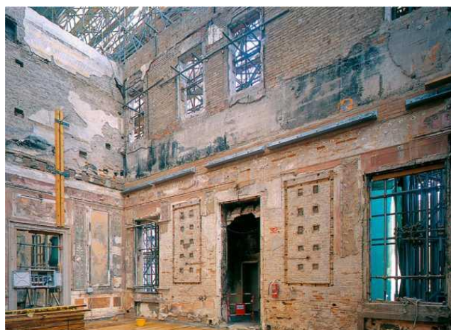
a) Escoramento das fachadas.
