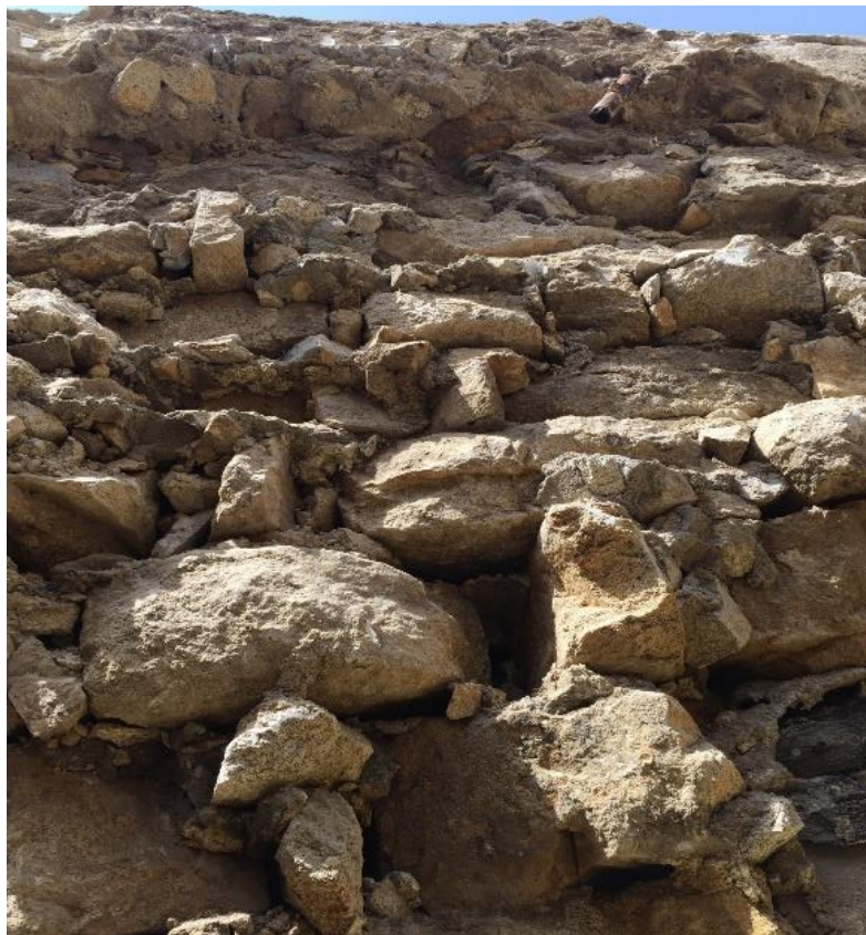
Figura 5.8 – Tardoz da parede da piscina, em alvenaria de pedra.
