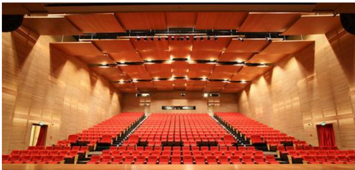
Figura 2.21 – Teto com difusores, teatro Iguatemi, Campinas [49].
