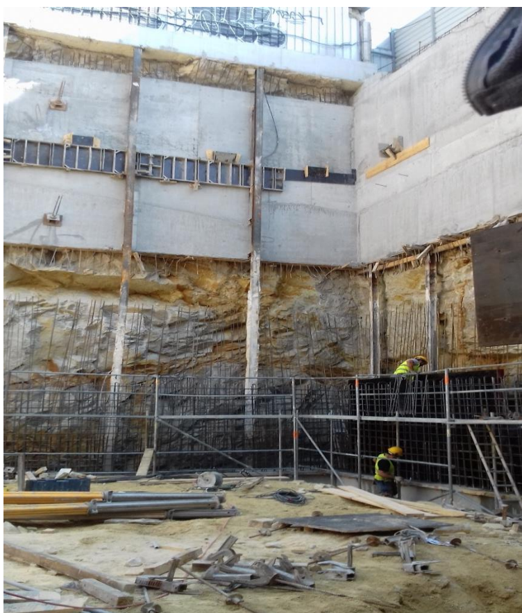
Figura 4.11 – Execução dos muros de contenção tipo Berlim definitivo.
