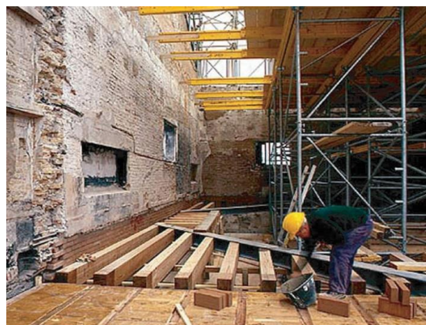
b) Colocação de piso em madeira.
