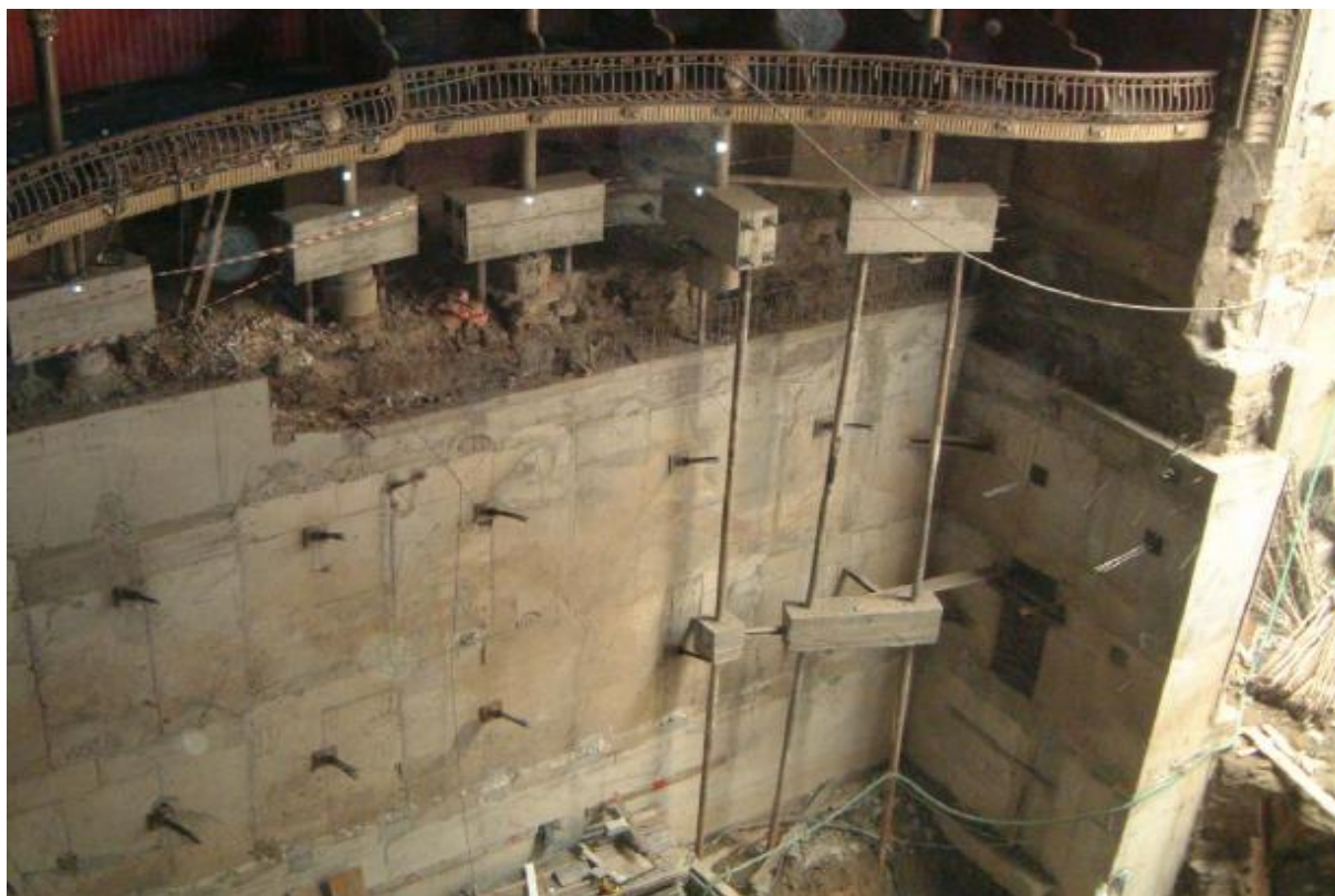
Figura 2.28 – Parede de contenção executada no Teatro Circo [10].
