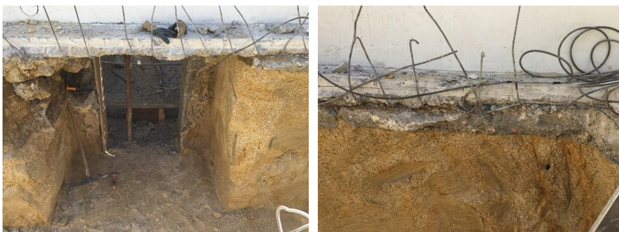
Figura 5.12 – Galeria para acesso de manutenção das tubagens.
