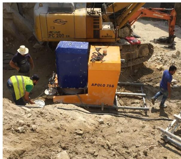
b) Colocação do fio diamantado.
